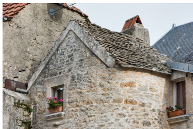
Détail de la toiture côté nord-ouest.
