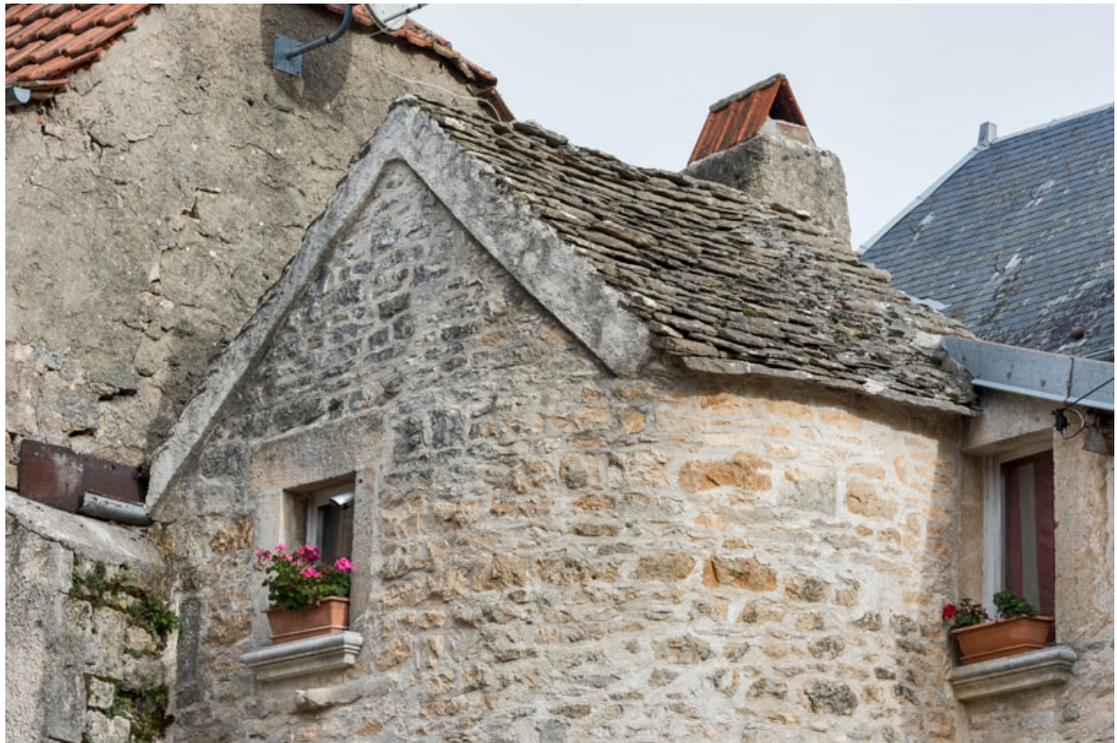
Détail de la toiture côté nord-ouest.
