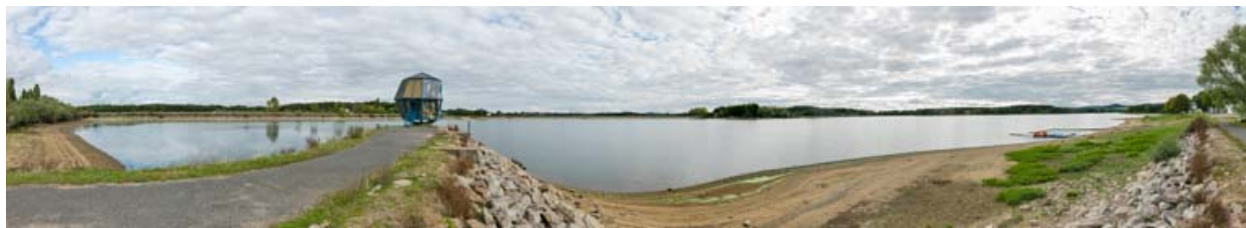
Vue générale du site.
