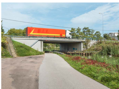
Vue d'ensemble du pont.
