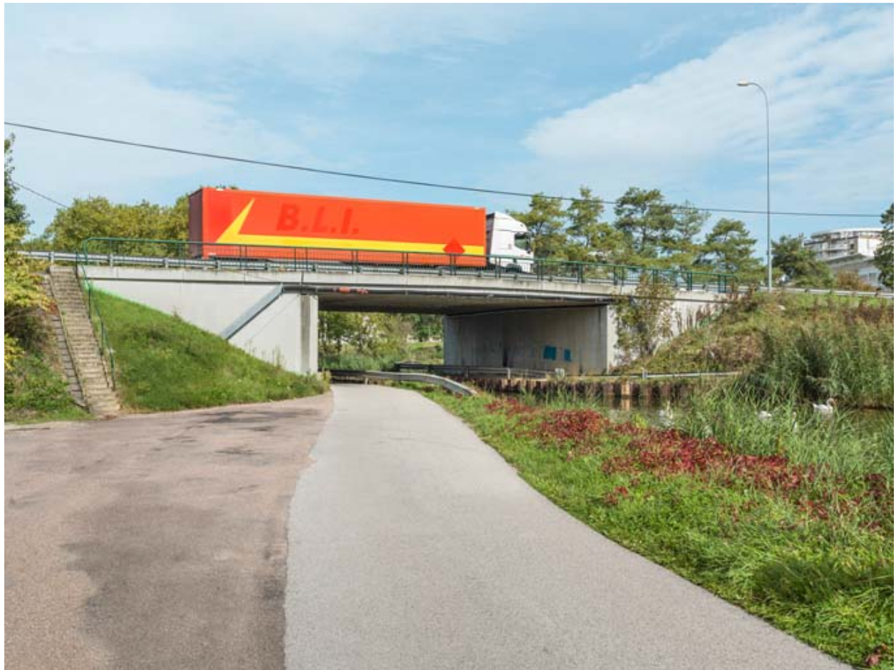
Vue d'ensemble du pont.
