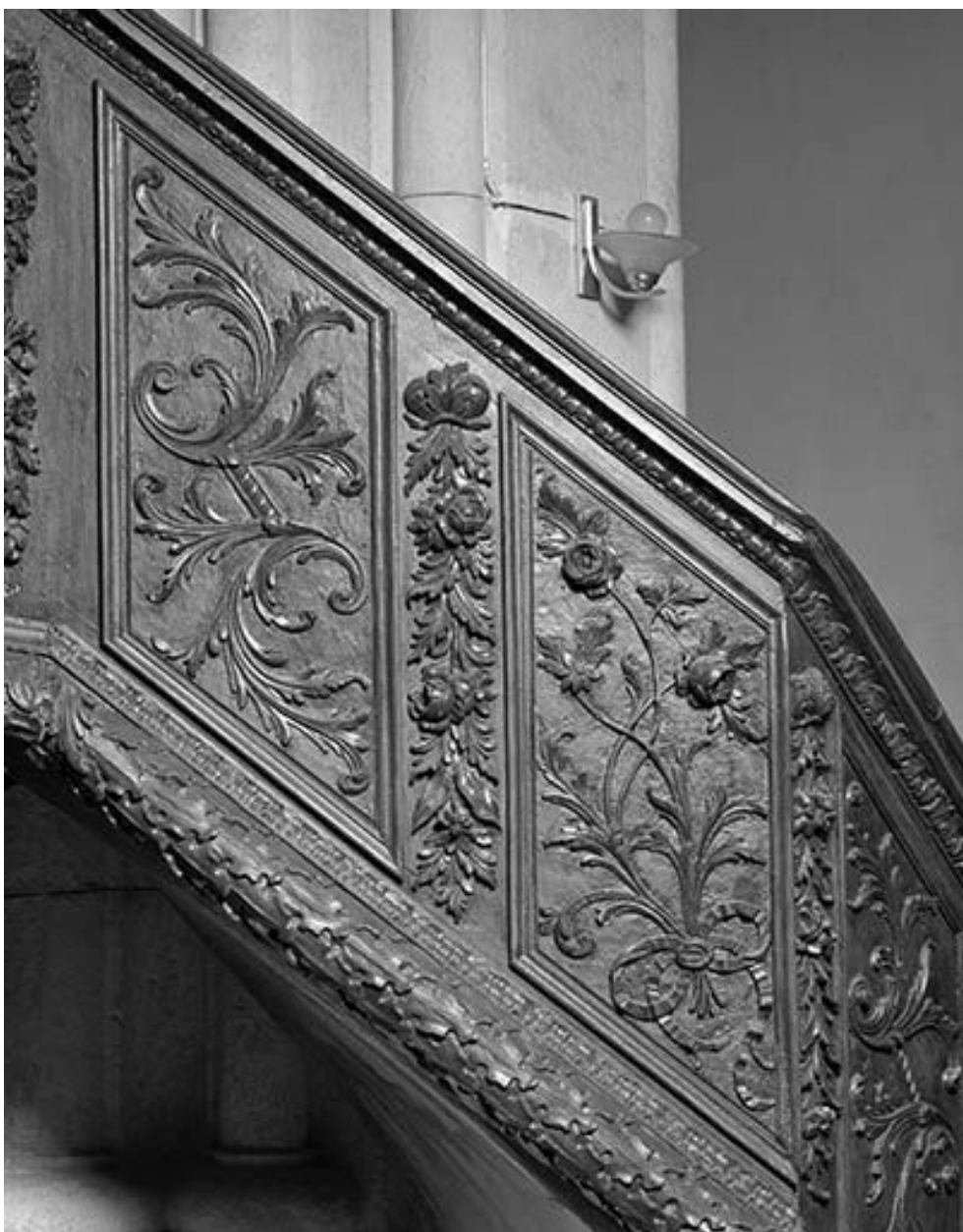
Panneaux de la rampe.
