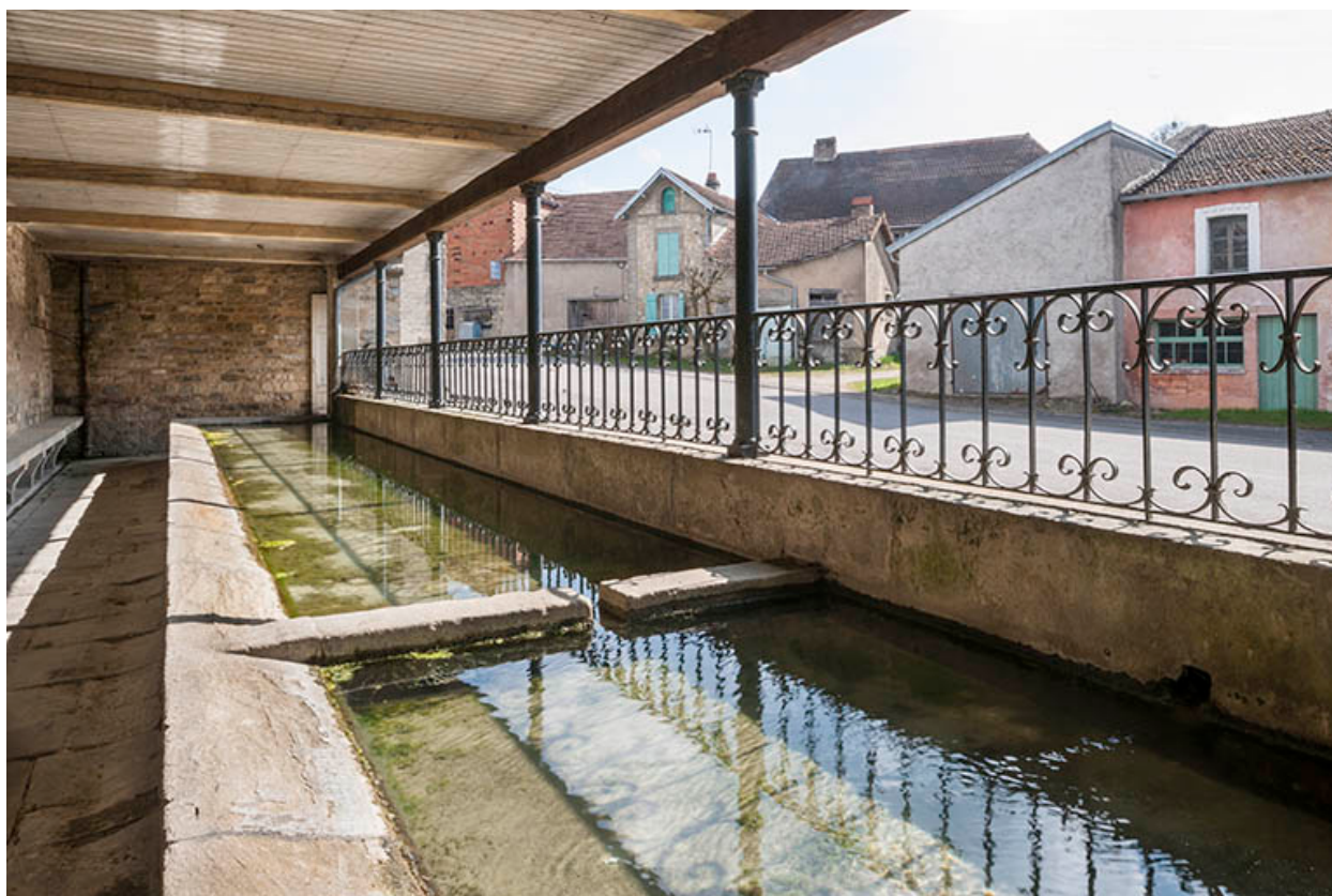
Lavoir, rue de la Vigne.
