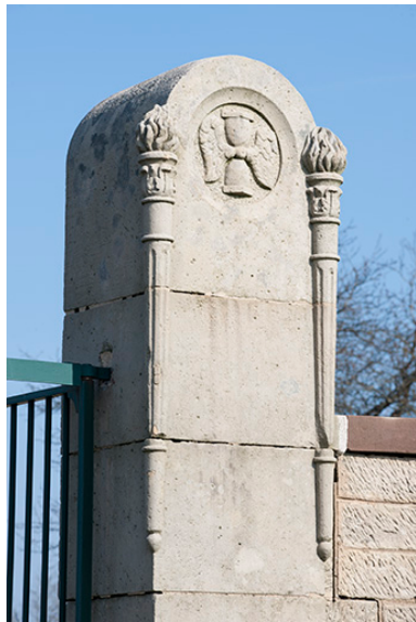
Détail d'un des piliers du portail. Phot. Jérôme Mongreville IVR43_20167000421NUC4A
