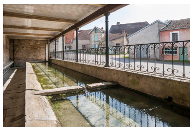
Lavoir, rue de la Vigne. Phot. Jérôme Mongreville IVR43_20167000445NUC4A
