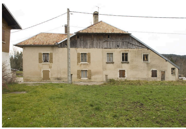
Façade latérale droite. Phot. Jérôme Mongreville IVR43_20082500836NUC2A
