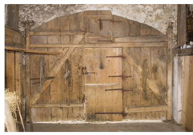
Façade antérieure : porte de la grange, depuis l'intérieur. Phot. Jérôme Mongreville IVR43_20082500837NUC2A
