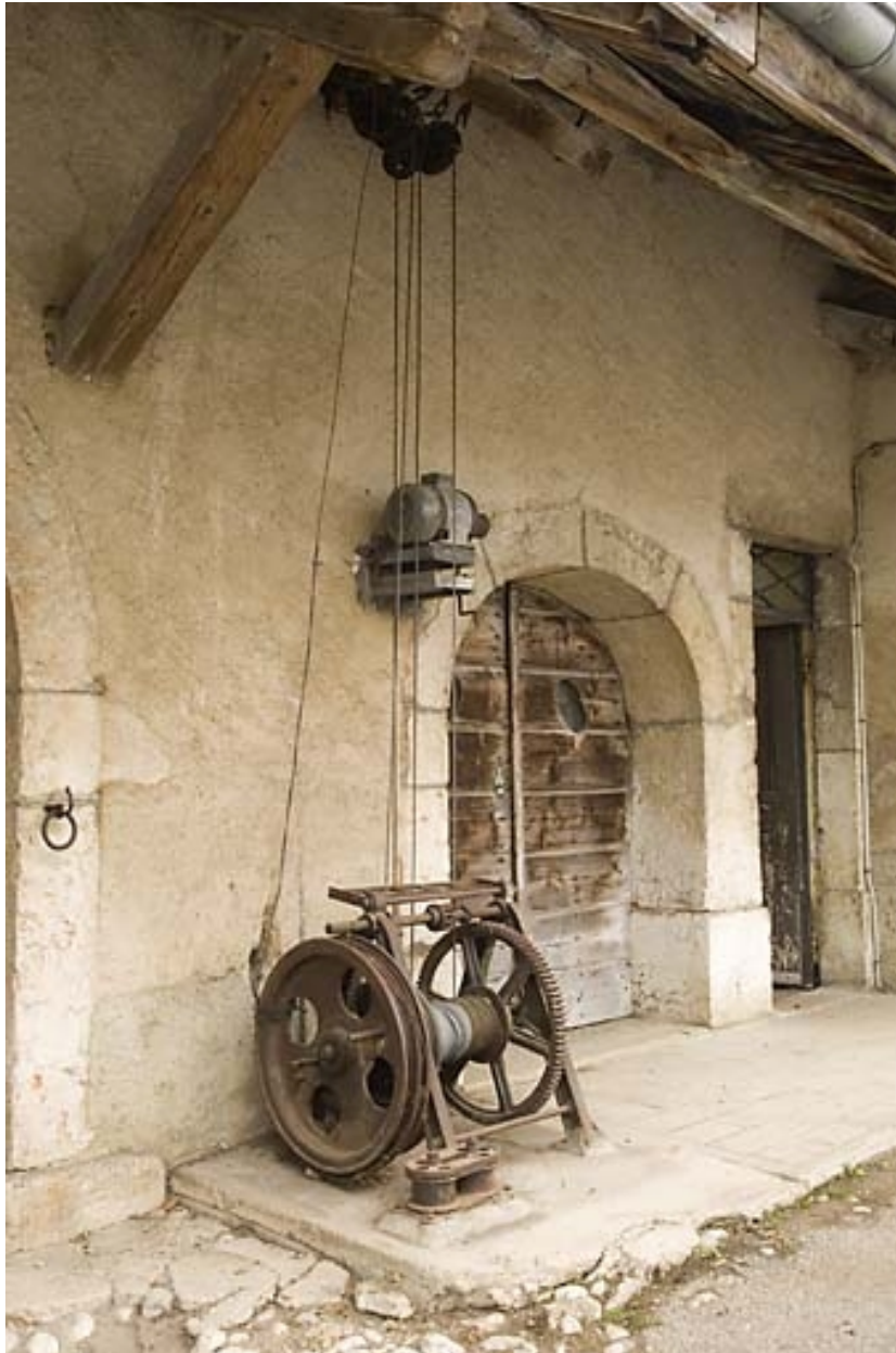
Déchargeuse : vue d'ensemble du treuil.
