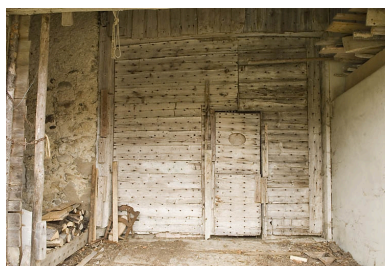
Façade postérieure : porte de la grange. Phot. Jérôme Mongreville IVR43_20082500835NUC2A
