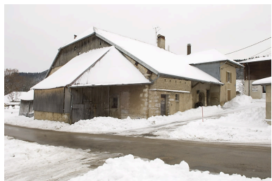
Façades antérieure et latérale gauche. Phot. Jérôme Mongreville IVR43_20082501011NUC2A
