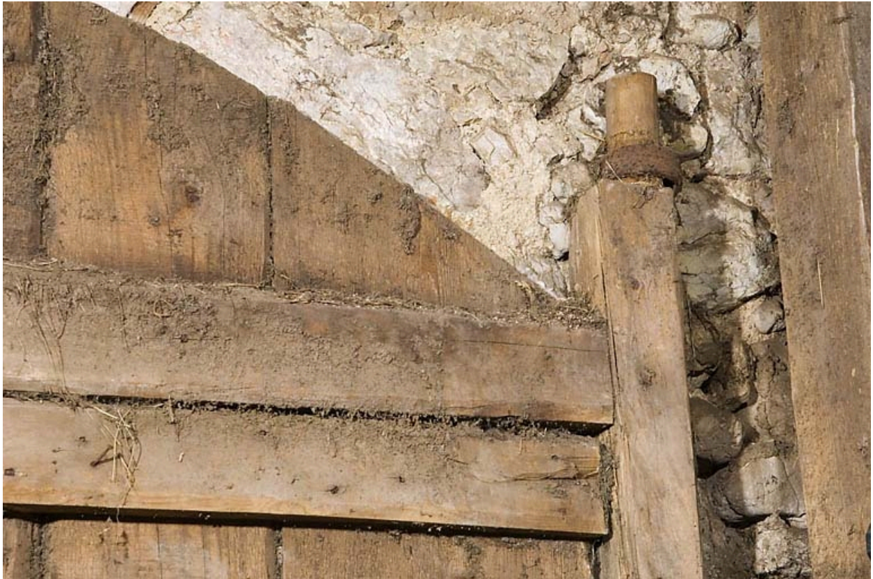
Façade antérieure, porte de grange : fixation de l'axe vertical du vantail de gauche (collier en partie haute).
