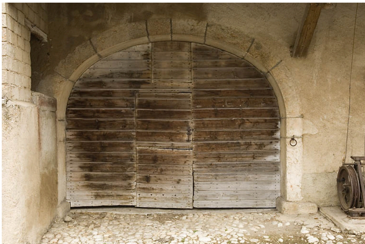
Façade antérieure : porte de la grange.
