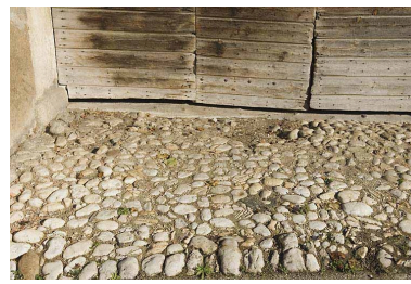
Façade antérieure : pavage devant la grange. Phot. Jérôme Mongreville IVR43_20082500842NUC2A
