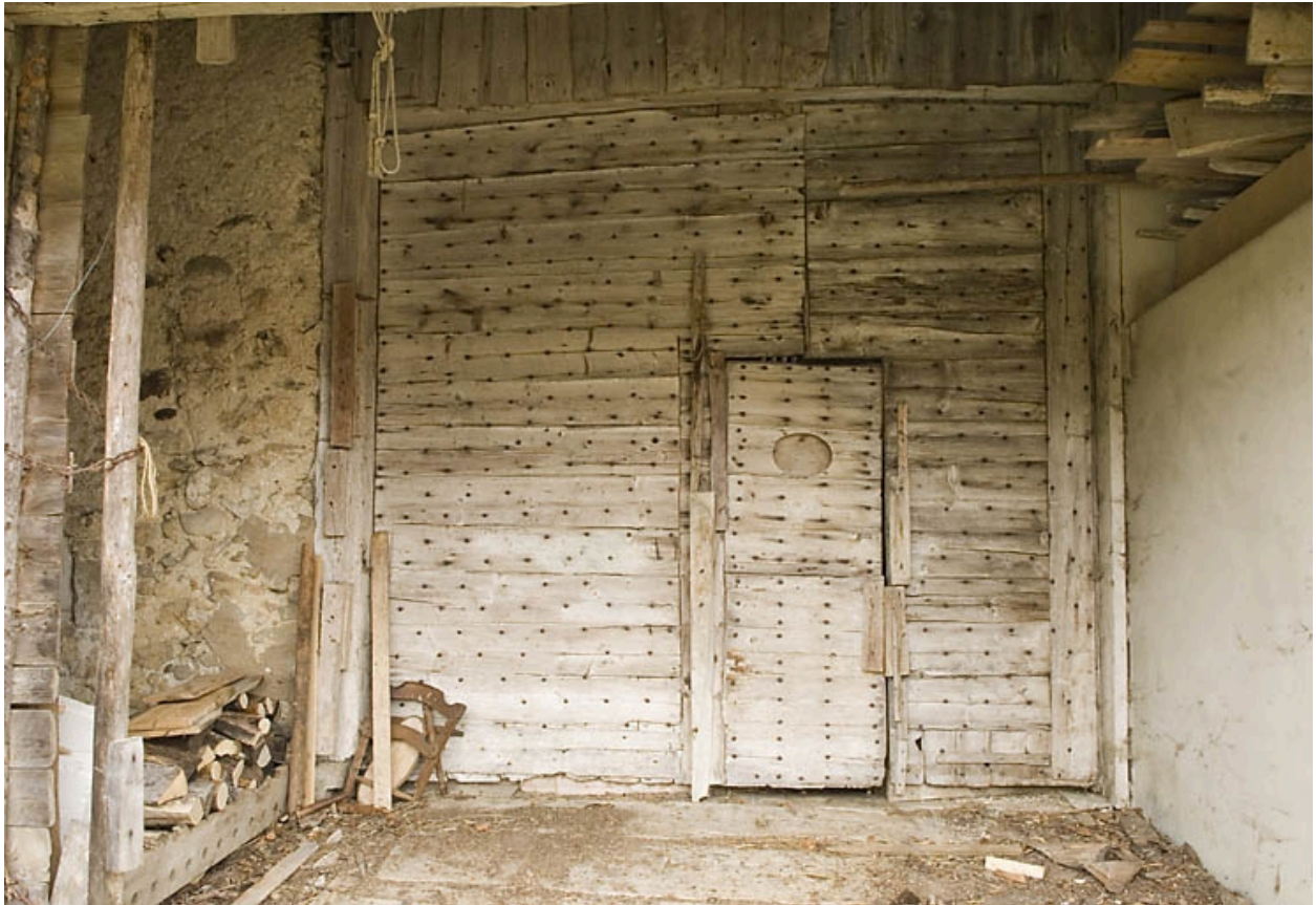
Façade postérieure : porte de la grange.
