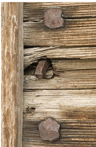
Façade postérieure : porte de la grange, clous à tête carrée. Phot. Jérôme Mongreville
