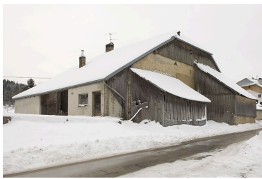
Façades postérieure et latérale gauche. Phot. Jérôme Mongreville IVR43_20082501012NUC2A
