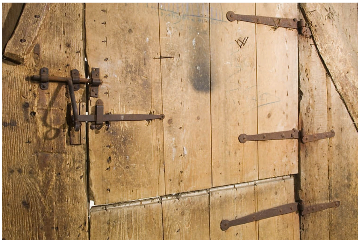
Façade antérieure, porte de grange : fermeture.
