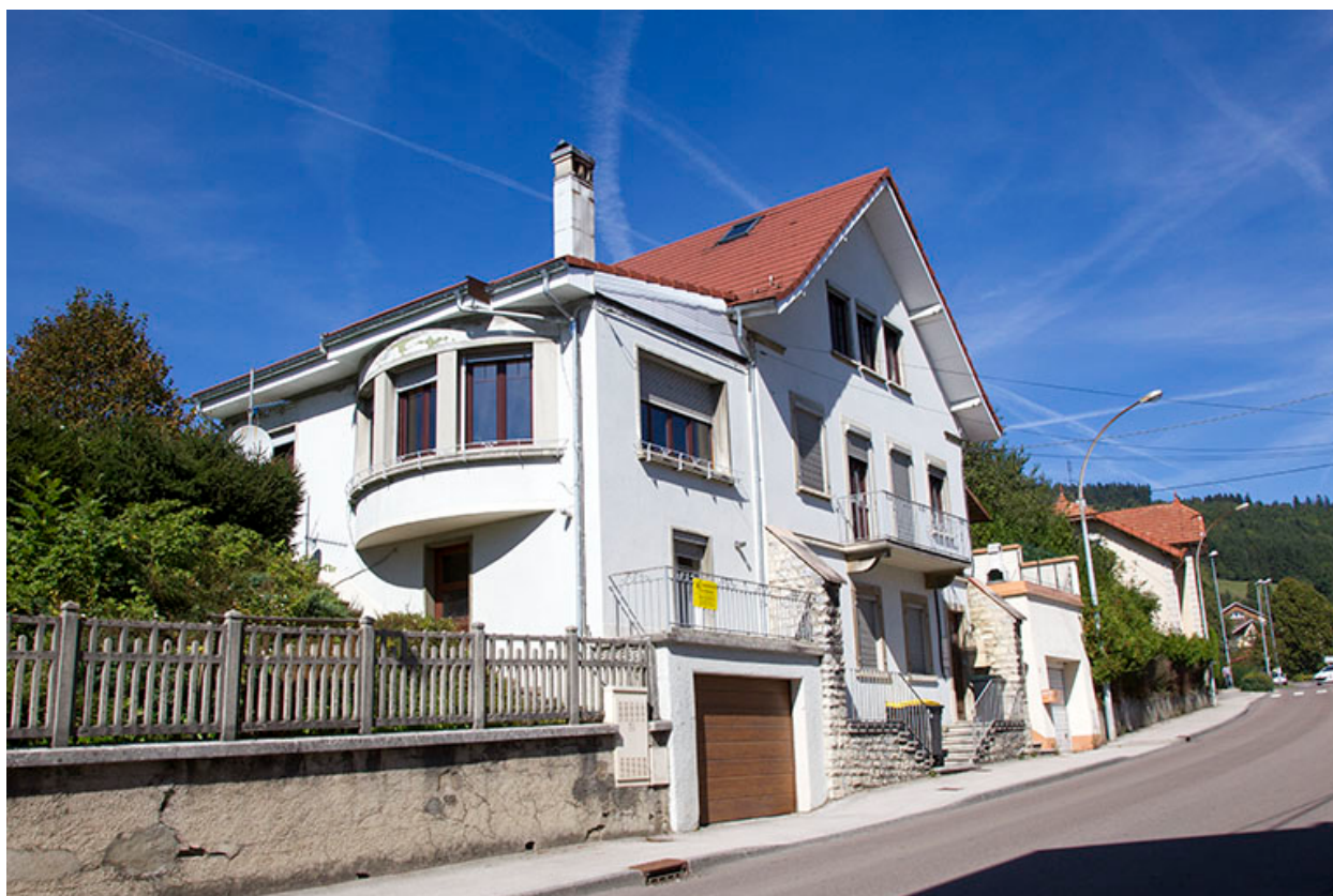
Façades antérieure et latérale gauche.
