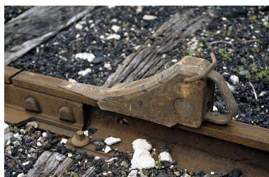
Vue d'ensemble. Phot. Yves Sancey IVR43_20053900802ZA
