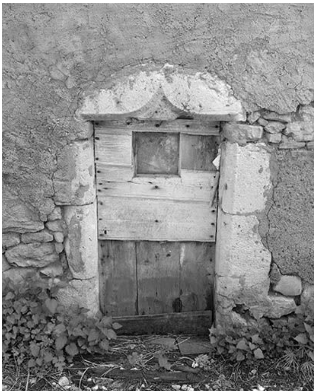
Linteau en accolade sur la façade postérieure.
