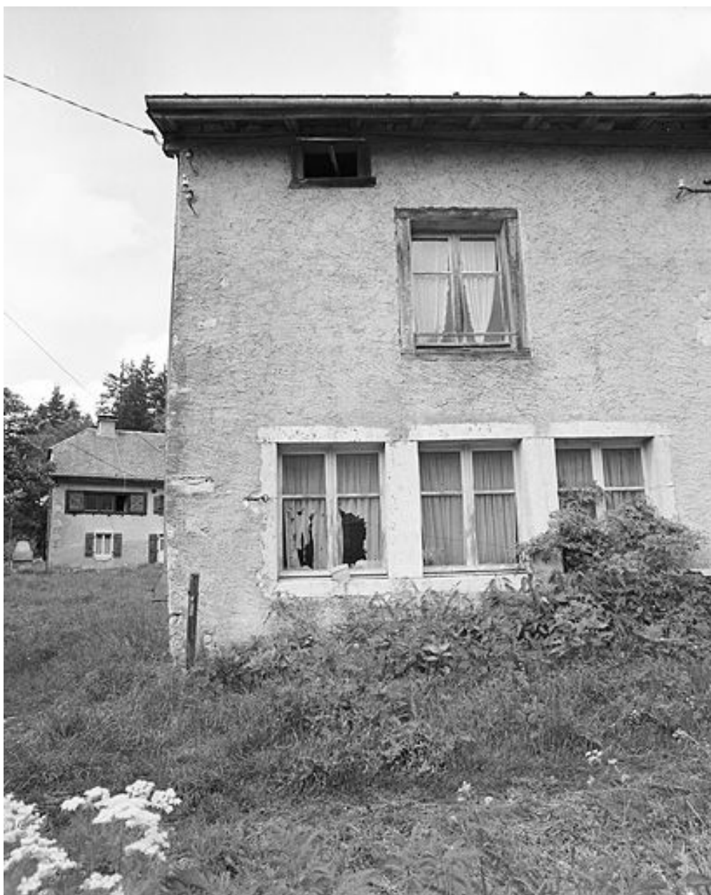
Les fenêtres de l'atelier.
