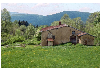
Face gauche et accès à la grange haute. Phot. Yves Sancey IVR43_19993900145ZA
