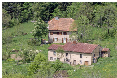
Vue de situation. Phot. Yves Sancey IVR43_19993900141ZA
