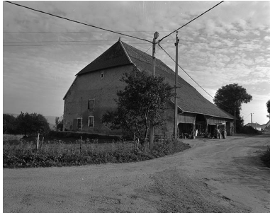
Vue générale. Phot. Bernard Lardière IVR43_19782500328X
