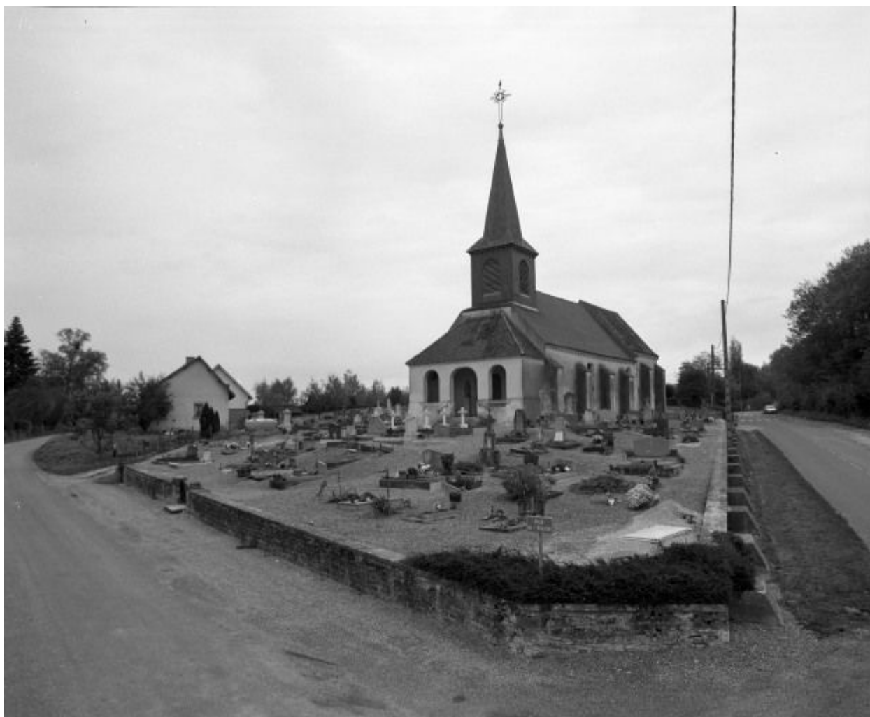
Vue d'ensemble, façade et élévation droite.
