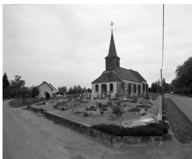
Vue d'ensemble, façade et élévation droite.
