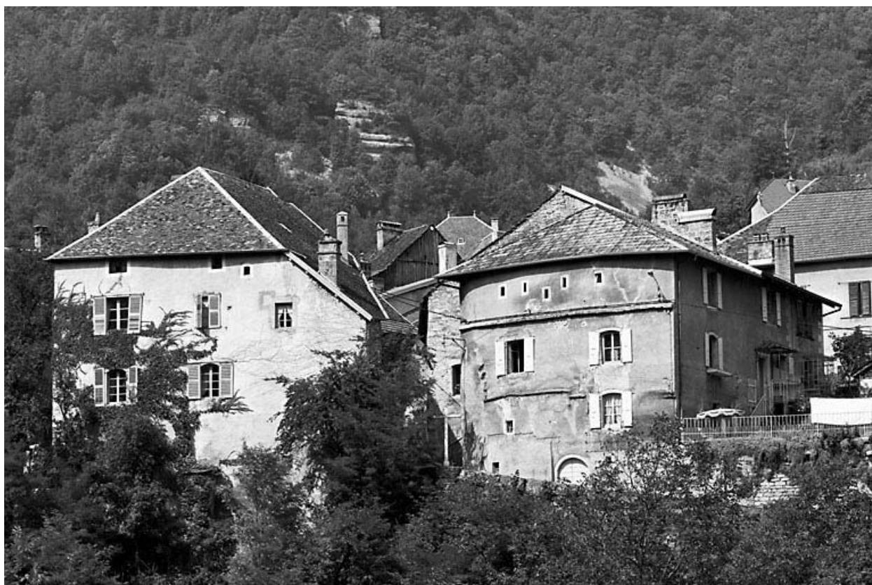
Elévation depuis le sud.
