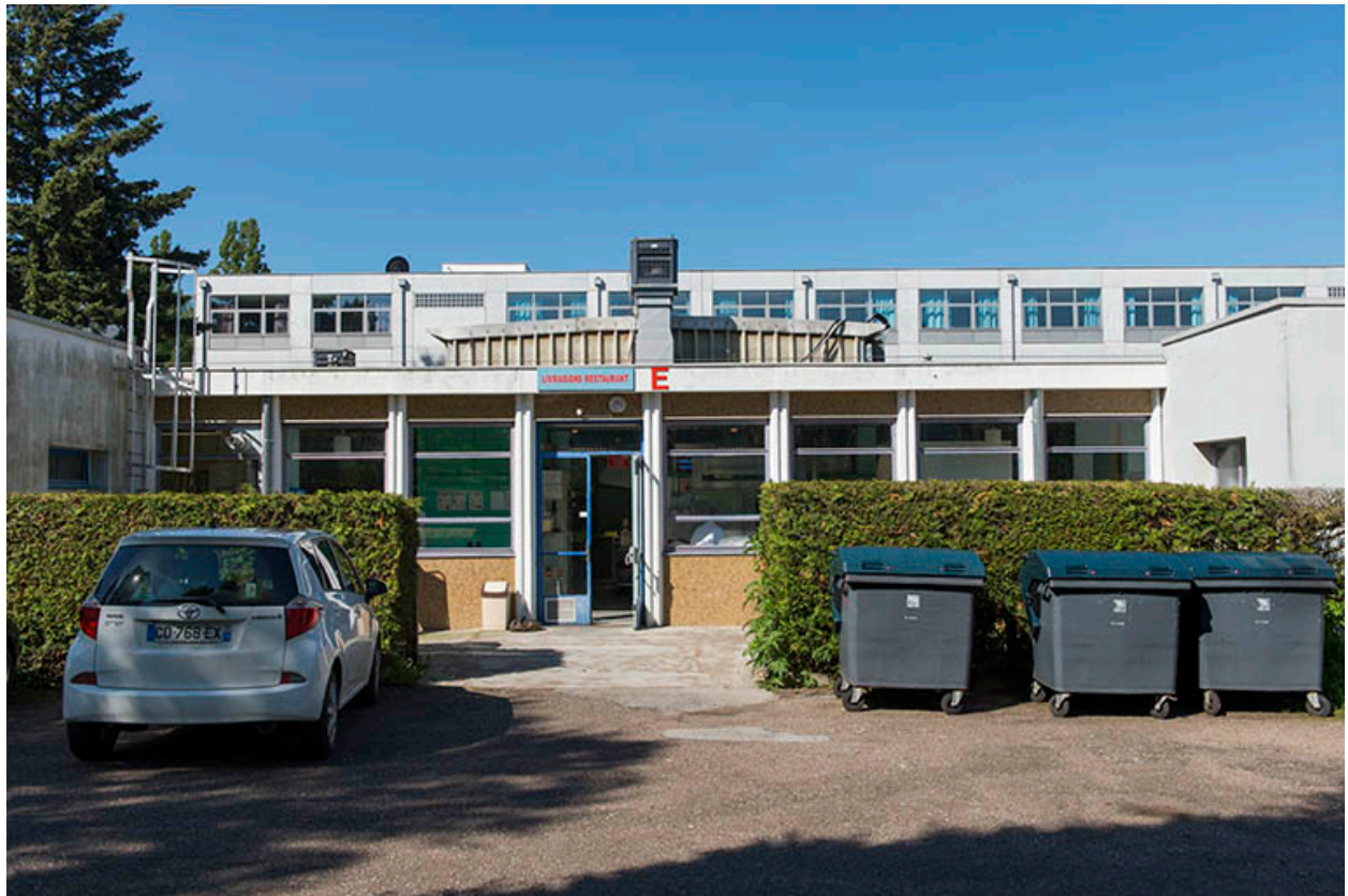
Façade postérieure est du bâtiment de restauration.
