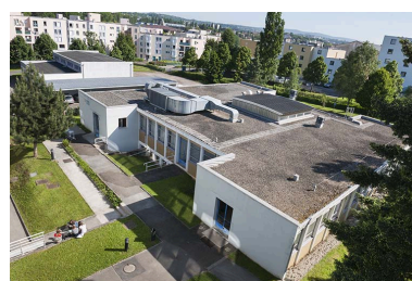
Angle sud-ouest du bâtiment de restauration. Phot. Jérôme Mongreville IVR43_20132500700NUC4A
