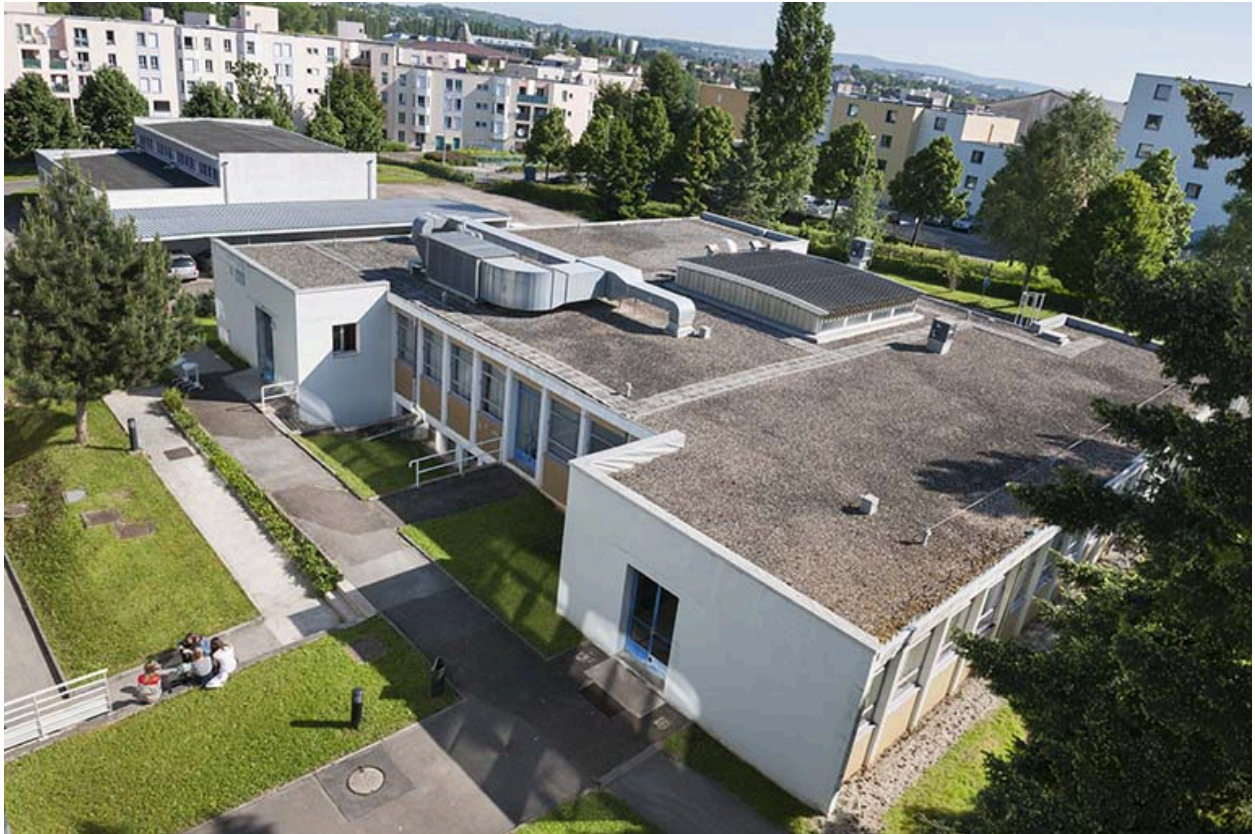
Angle sud-ouest du bâtiment de restauration.
