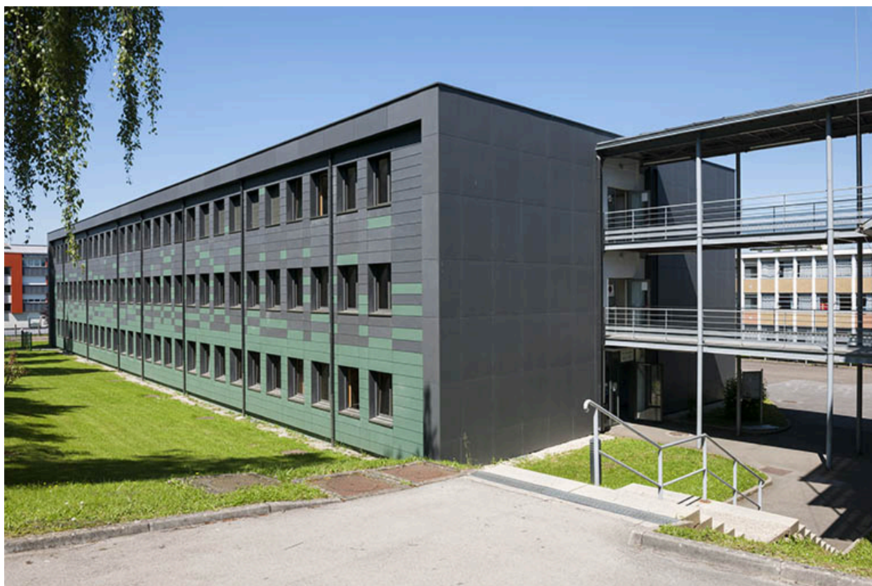
Façade sud et pignon est de l'externat.
