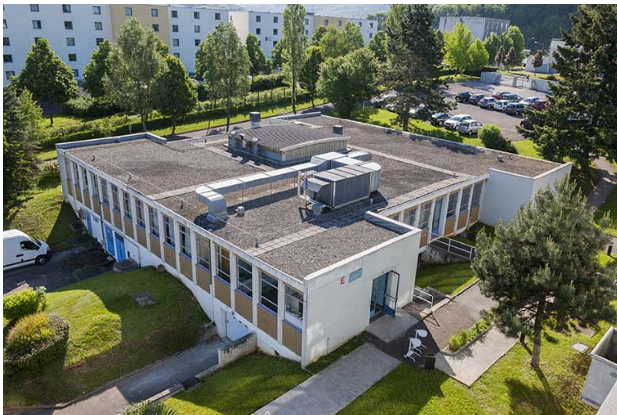
Angle nord-ouest du bâtiment de restauration.
