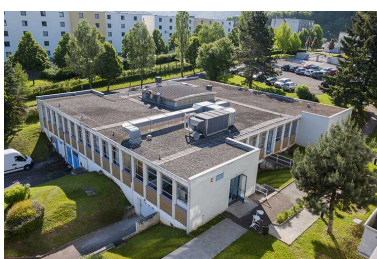
Angle nord-ouest du bâtiment de restauration. Phot. Jérôme Mongreville IVR43_20132500698NUC4A
