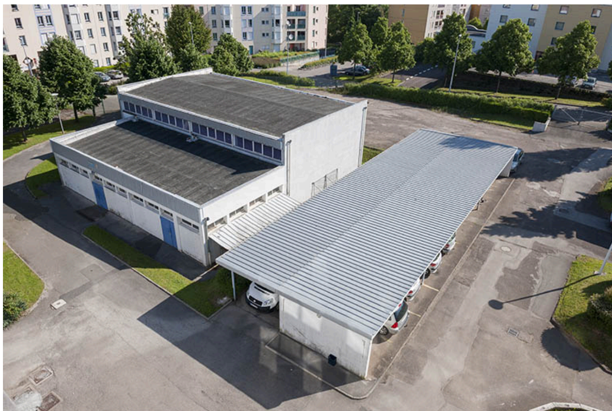
Angle sud des gymnase et garage
