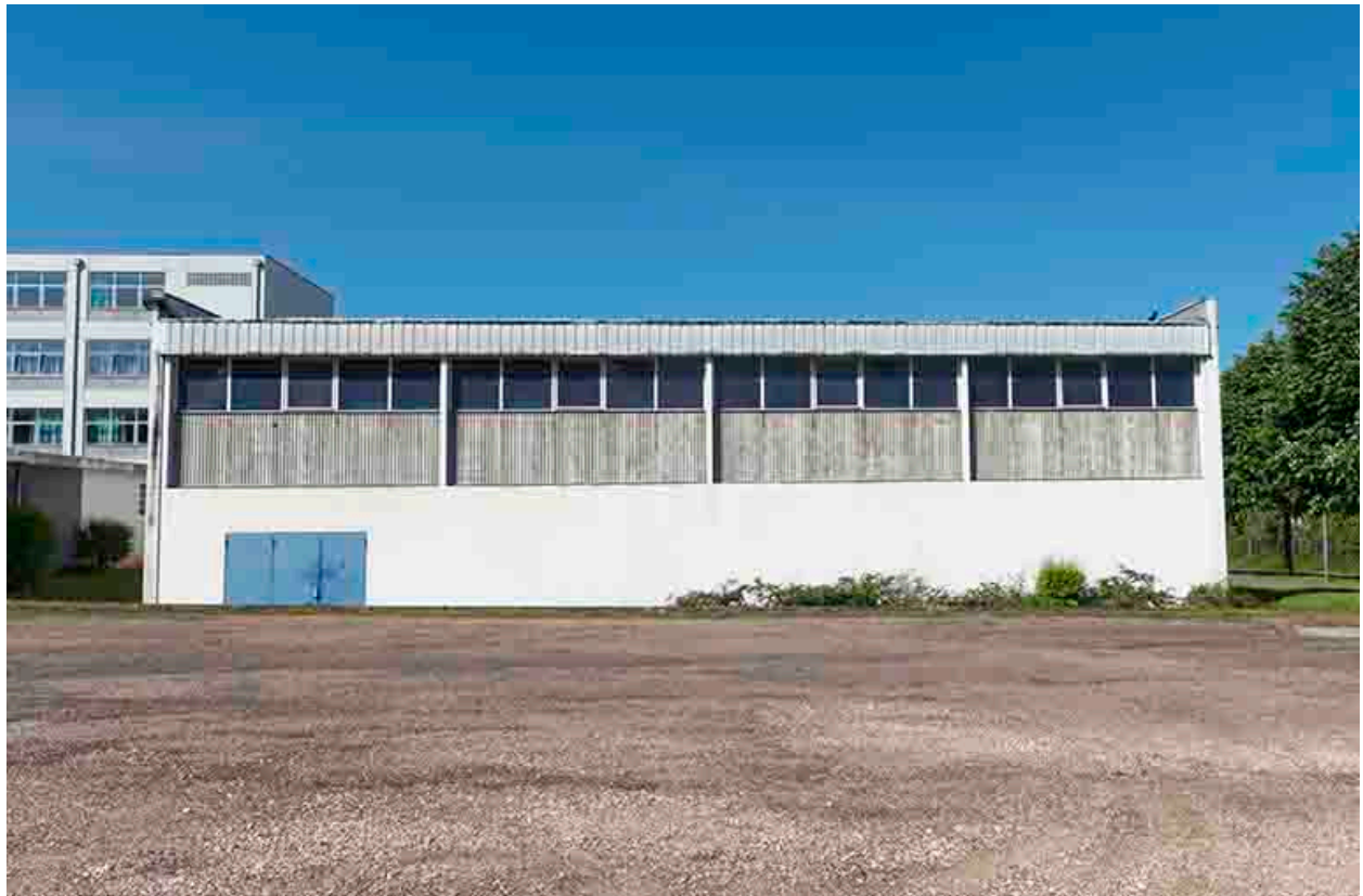
Façade nord-est du gymnase.
