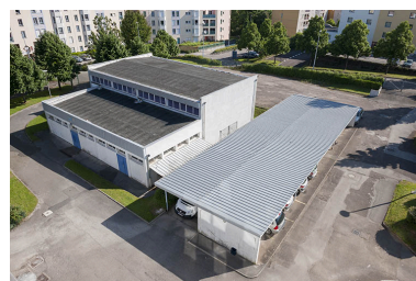
Angle sud des gymnase et garage Phot. Jérôme Mongreville IVR43_20132500699NUC4A
