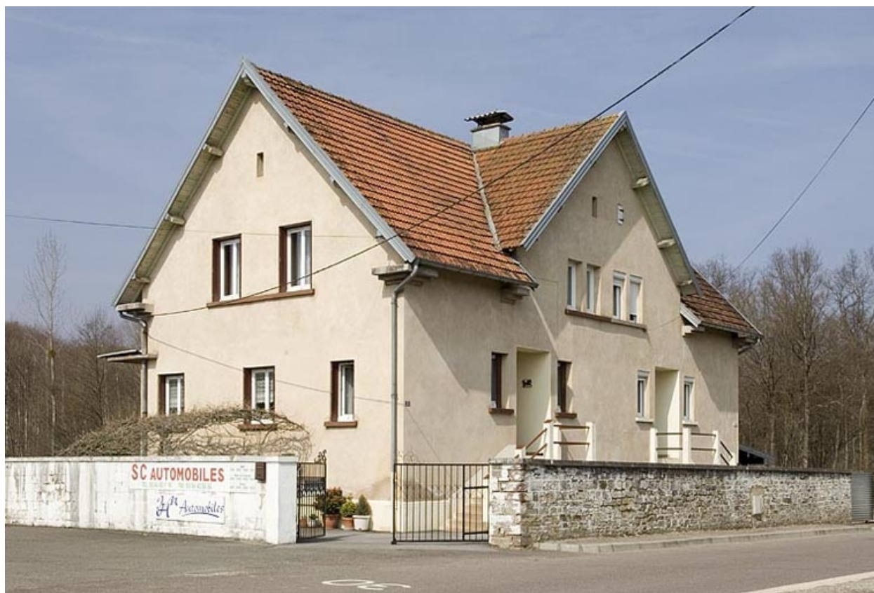
Logement de cadres (?). Vue de trois quarts.
