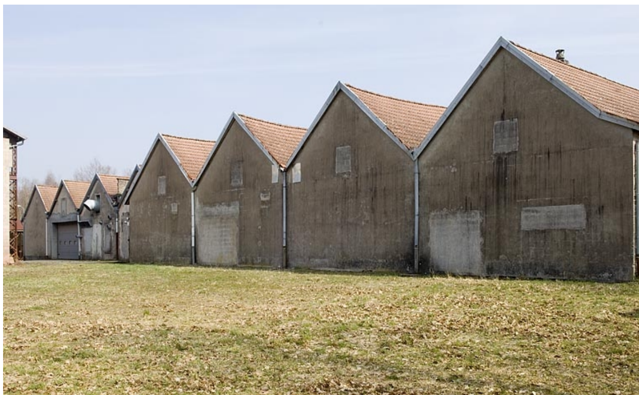
Pignons ouest de l'atelier de filature.
