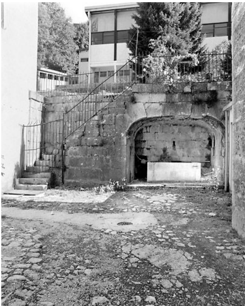
Fontaine, escalier isolé et mur de soutènement.
