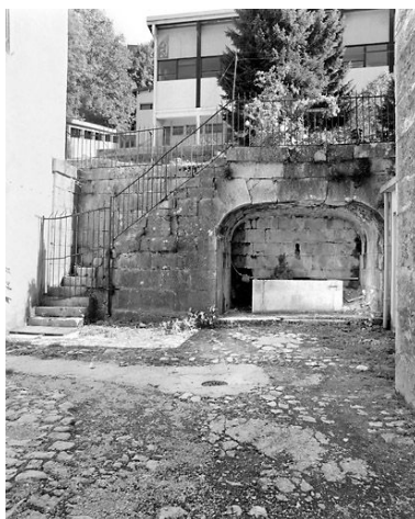
Mur de soutènement, escalier isolé et fontaine. Phot. Yves Sancey IVR43_20033900767X
