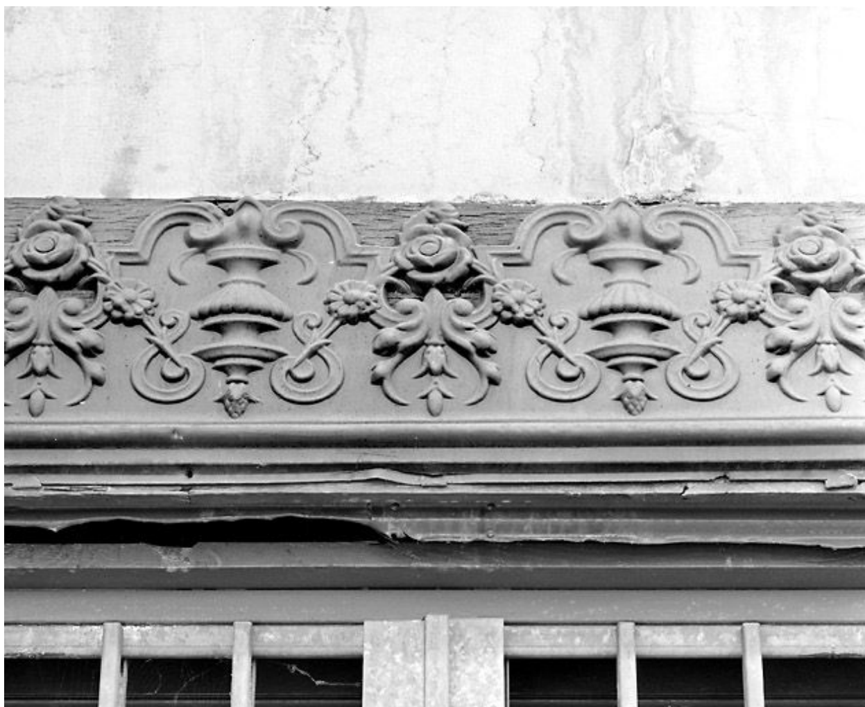
Façade latérale gauche : détail du décor.
