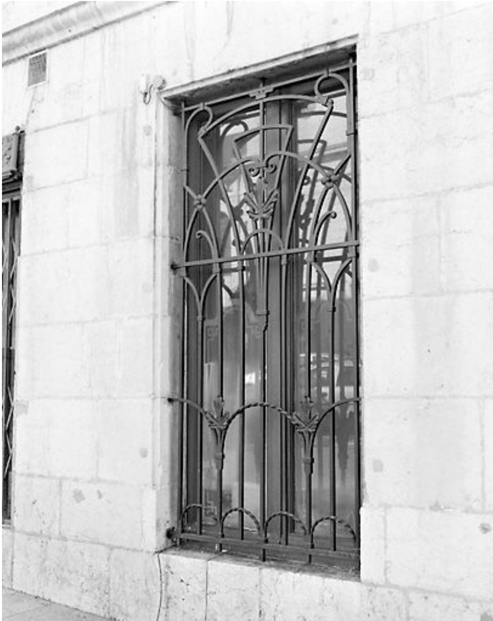
Façade latérale gauche : grille Art déco.
