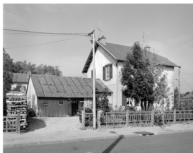
Face postérieure et face latérale droite. Phot. Yves Sancey IVR43_19893900539X
