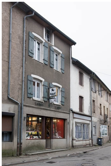
Vue générale de trois quarts gauche. Phot. Jérôme Mongreville IVR43_20112502925NUC4A
