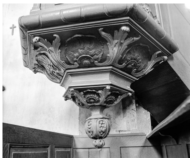
Détail : culot. Phot. Yves Sancey IVR43_19777000126X
