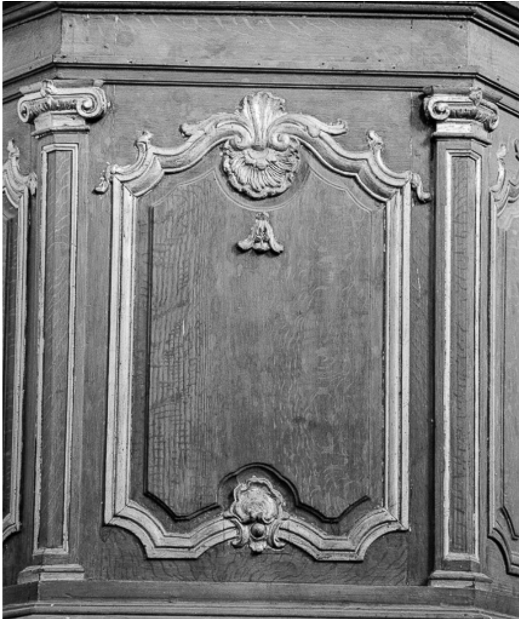
Détail d'un panneau de la cuve.
