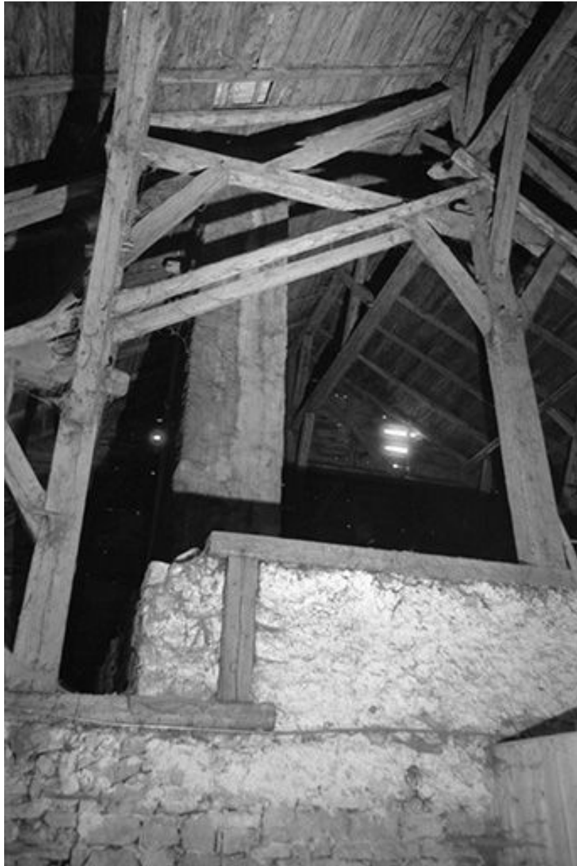
Intérieur : charpente et cheminée.
