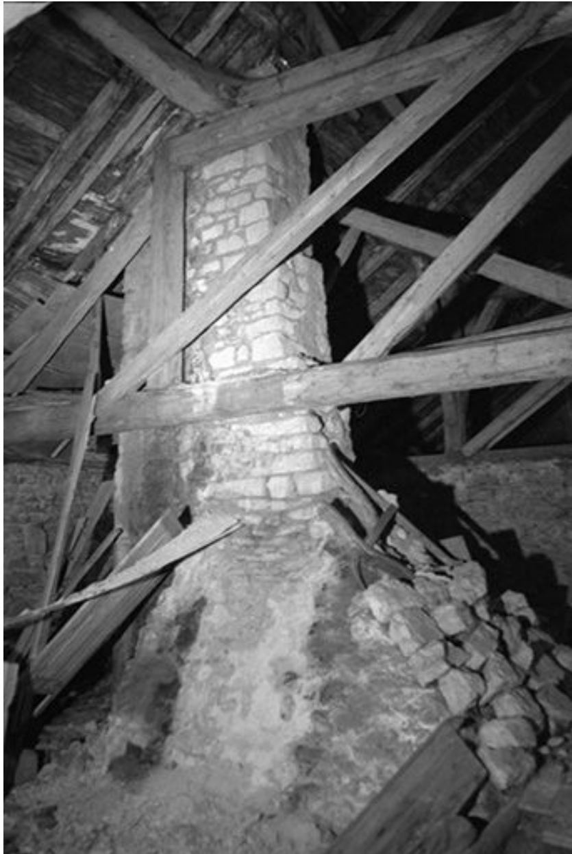
Intérieur : charpente et cheminée.
