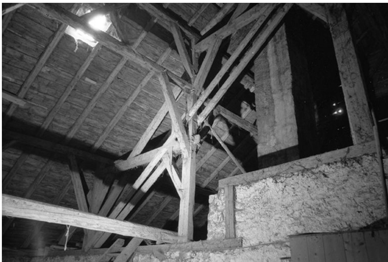
Intérieur : charpente et cheminée.
