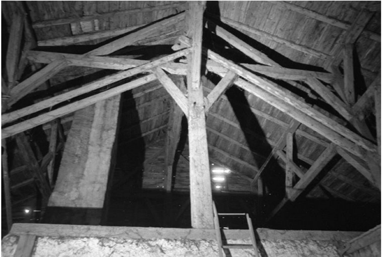
Intérieur : charpente et cheminée.
