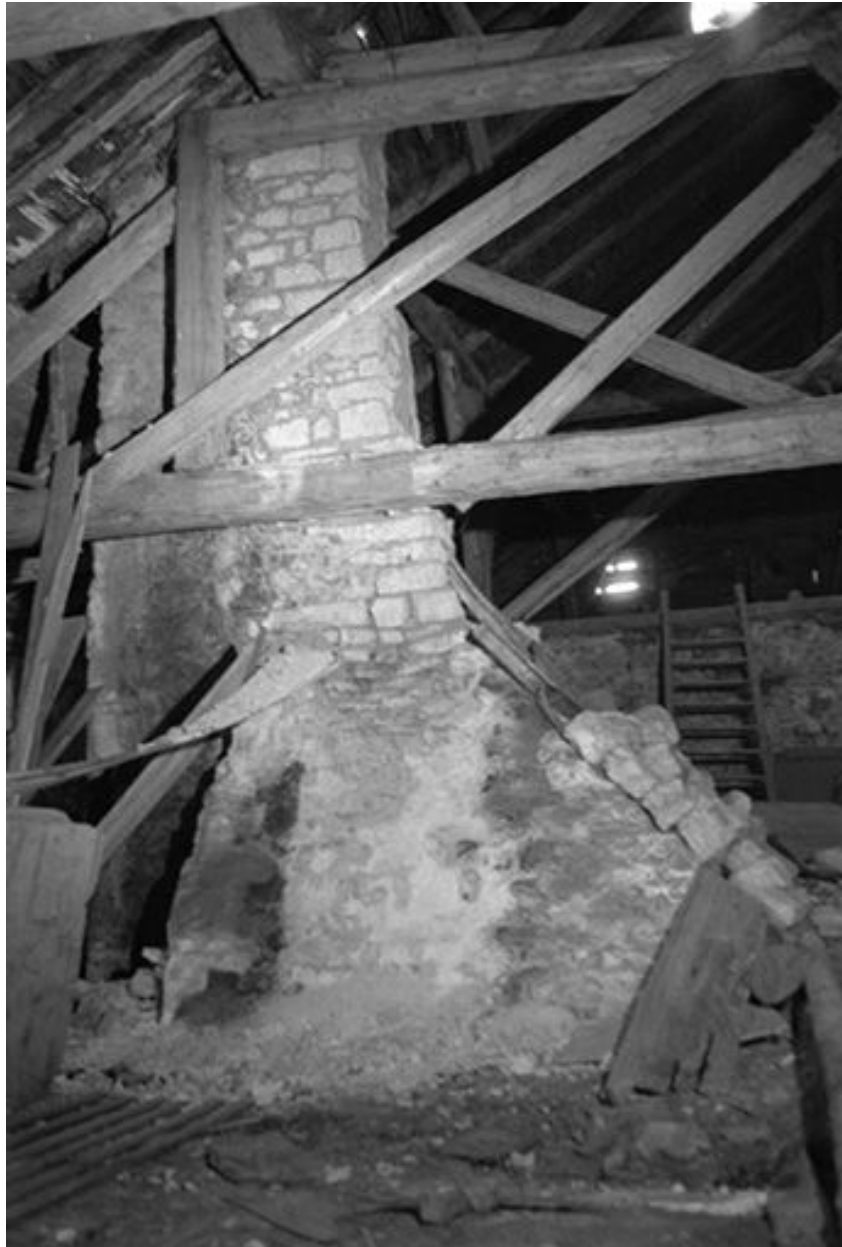
Intérieur : charpente et cheminée.
