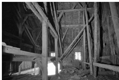
Intérieur : charpente. Phot. Gilbert Poinot IVR43_19752501027Z
