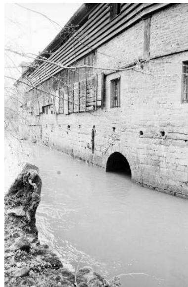
Atelier de fabrication (?) en 1979. Façade sur la Brenne. Phot. Jack Dumont IVR43_19793900426Z
