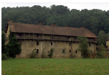
Logement d'ouvriers (D).Façade postérieure longeant la Brenne. Phot. Jérôme Mongreville IVR43_19953900523ZA
