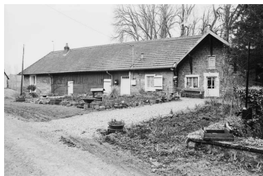
Façade antérieure d'un logement ouvrier. Phot. Jack Dumont IVR43_19793900442Z
