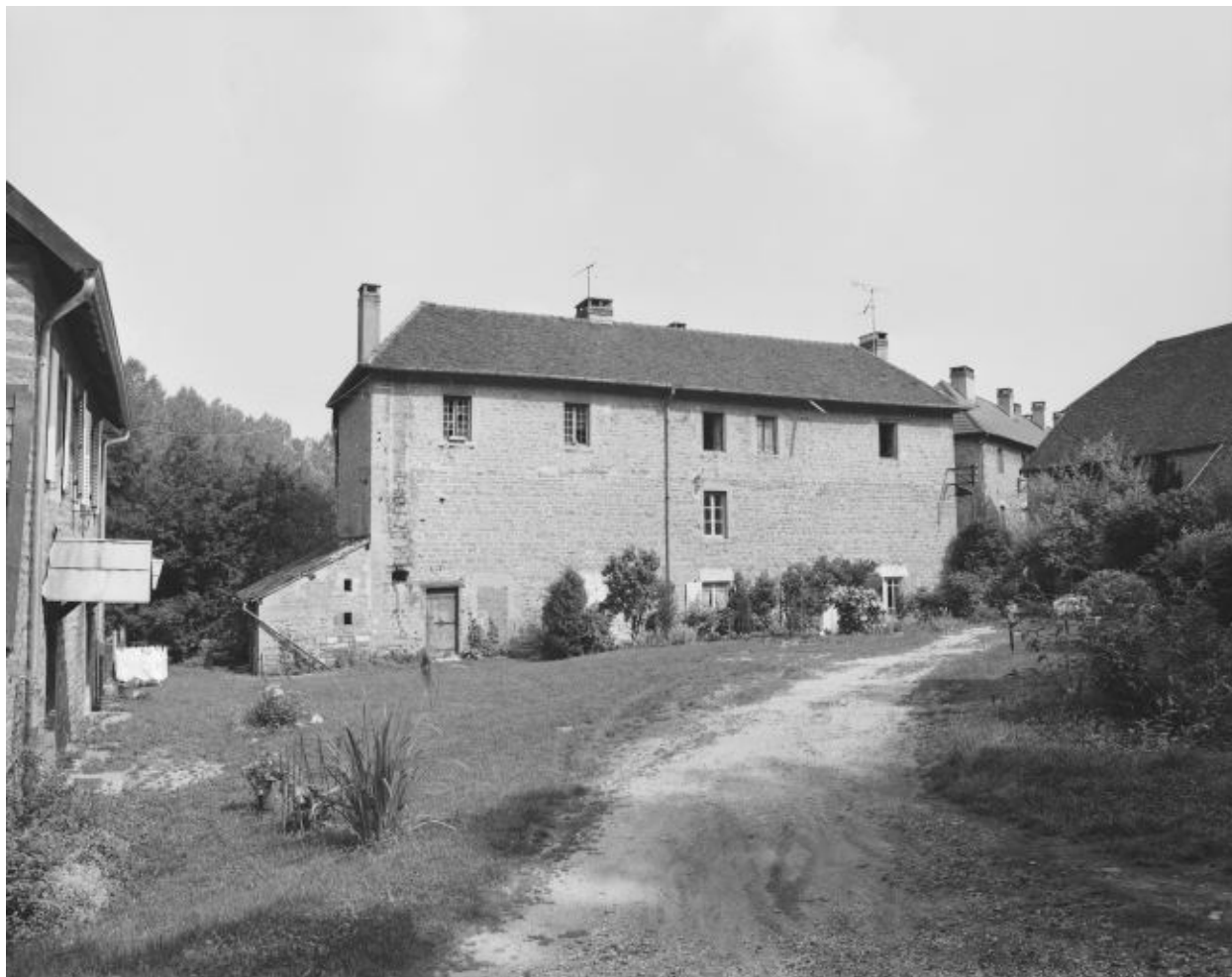
Logement d'ouvriers (C) en 1980. Façade postérieure vue depuis l'ouest.
