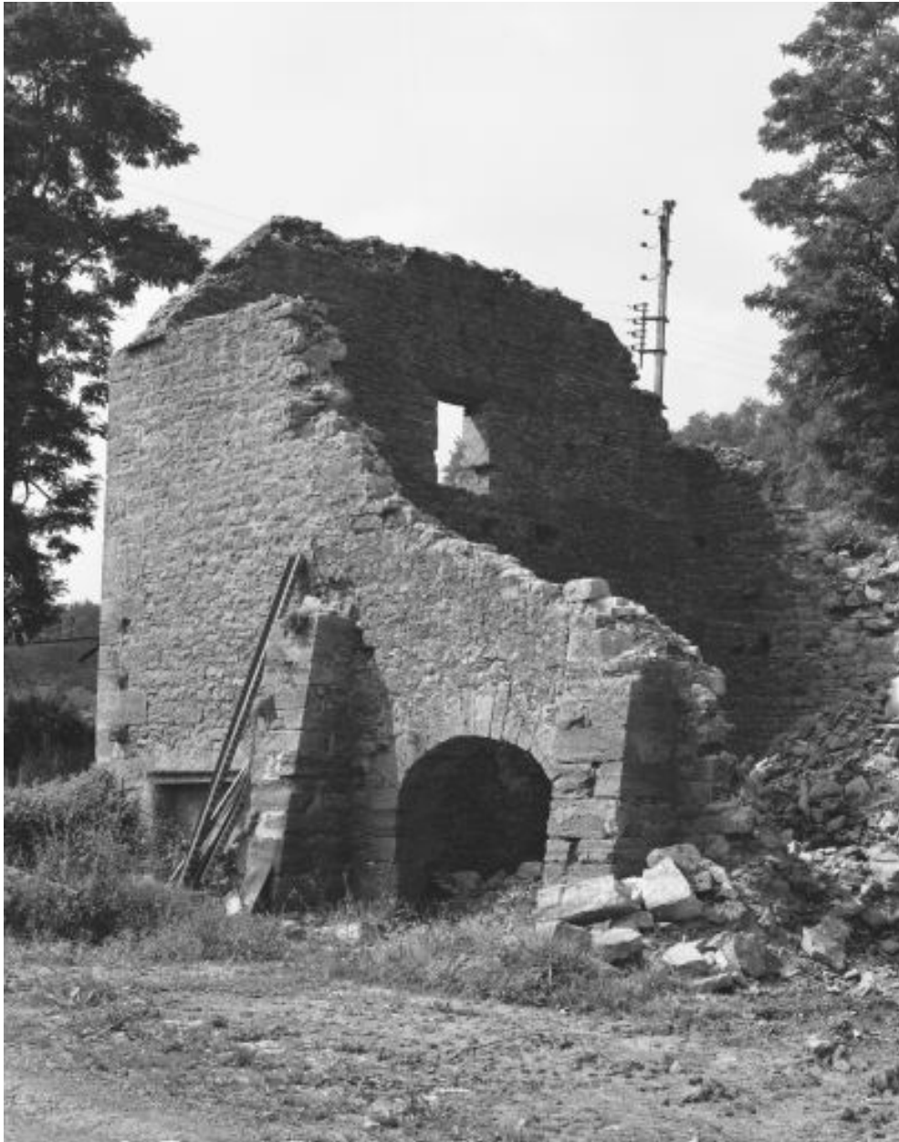
Vestiges du magasin industriel (hangar à sable et à bois) en 1980.
