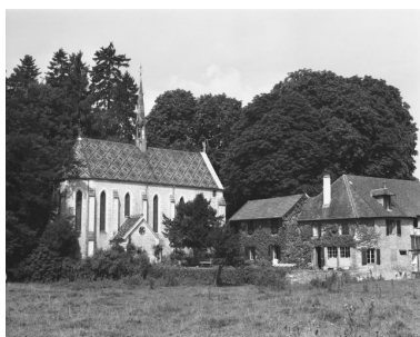
Chapelle et école depuis l'est. Phot. Dominique Dominguez IVR43_19803900274X
