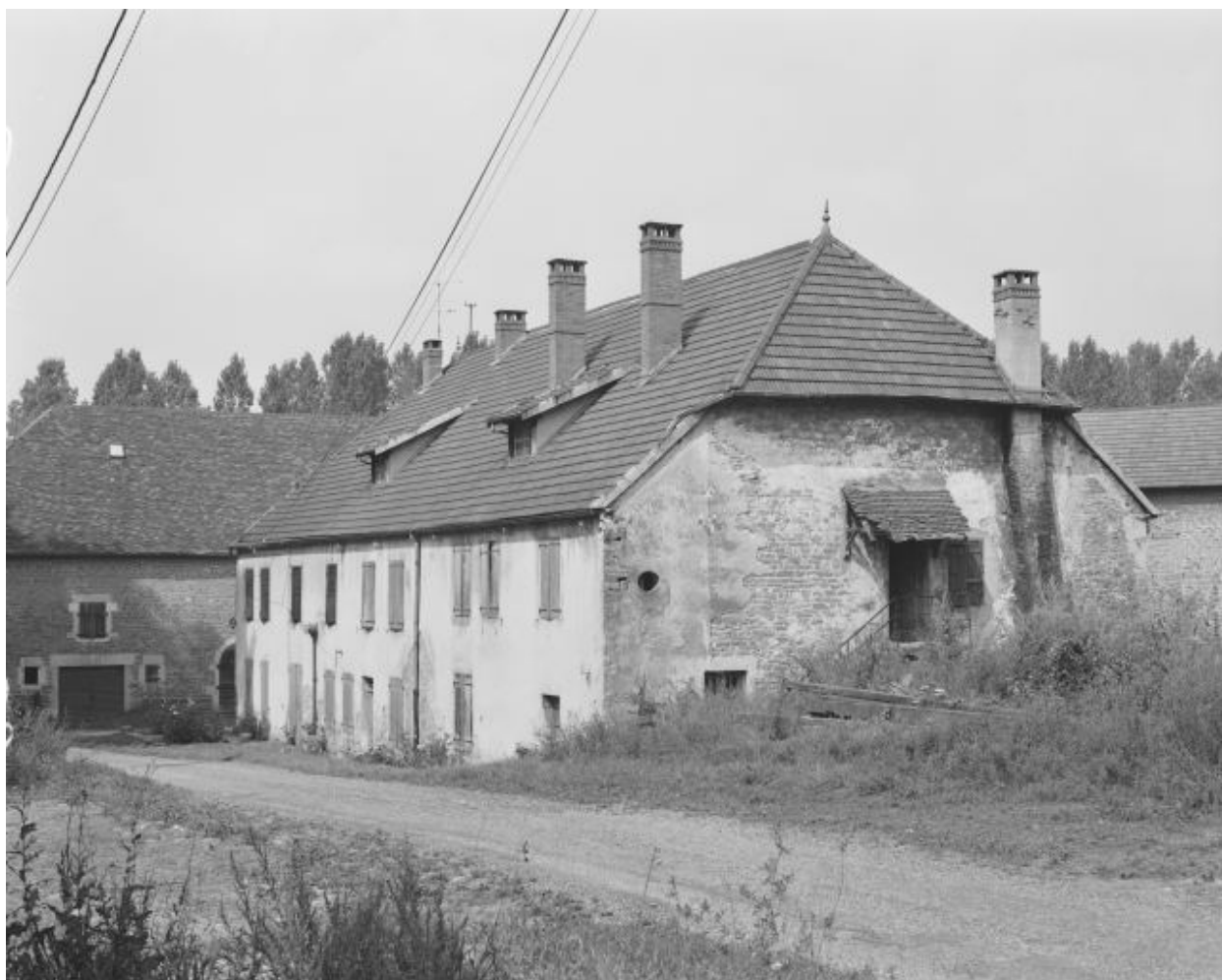
Logement patronal depuis le sud-ouest.
