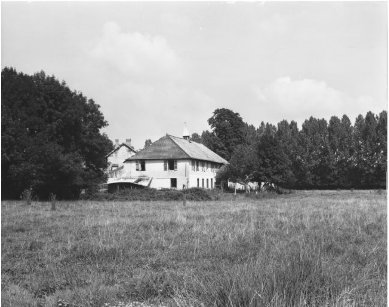
Le presbytère depuis le sud-est.
