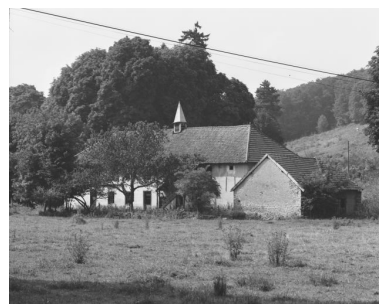
Façade postérieure du presbytère. Phot. Dominique Dominguez IVR43_19803900289X
