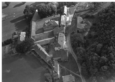
Vue aérienne en 1956. Phot. Roger Henrard IVR43_19563900170N
