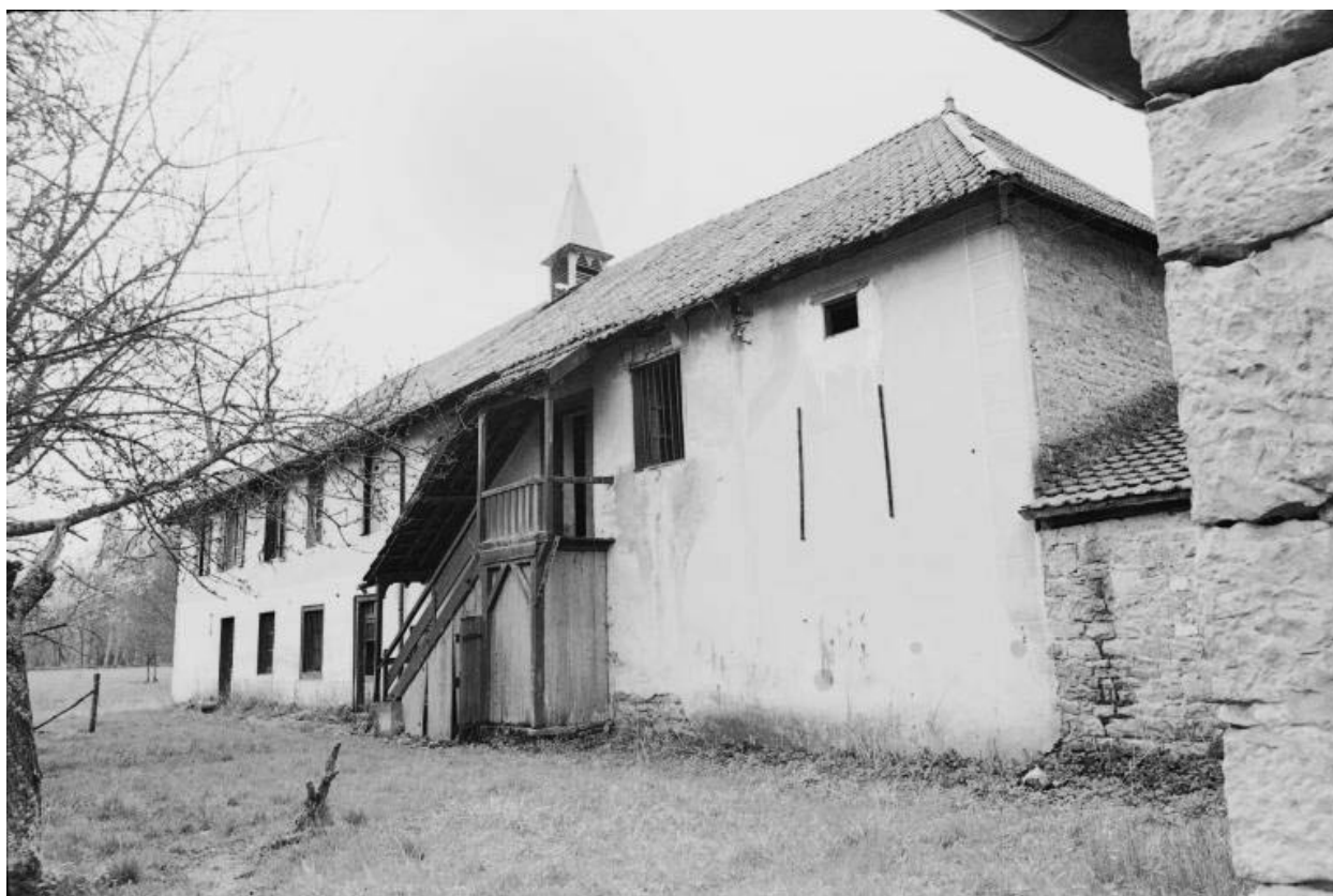
Façade postérieure du presbytère, vue de trois quarts.
