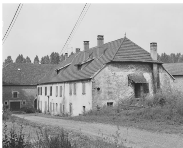
Logement patronal depuis le sud-ouest. Phot. Dominique Dominguez IVR43_19803900283X
