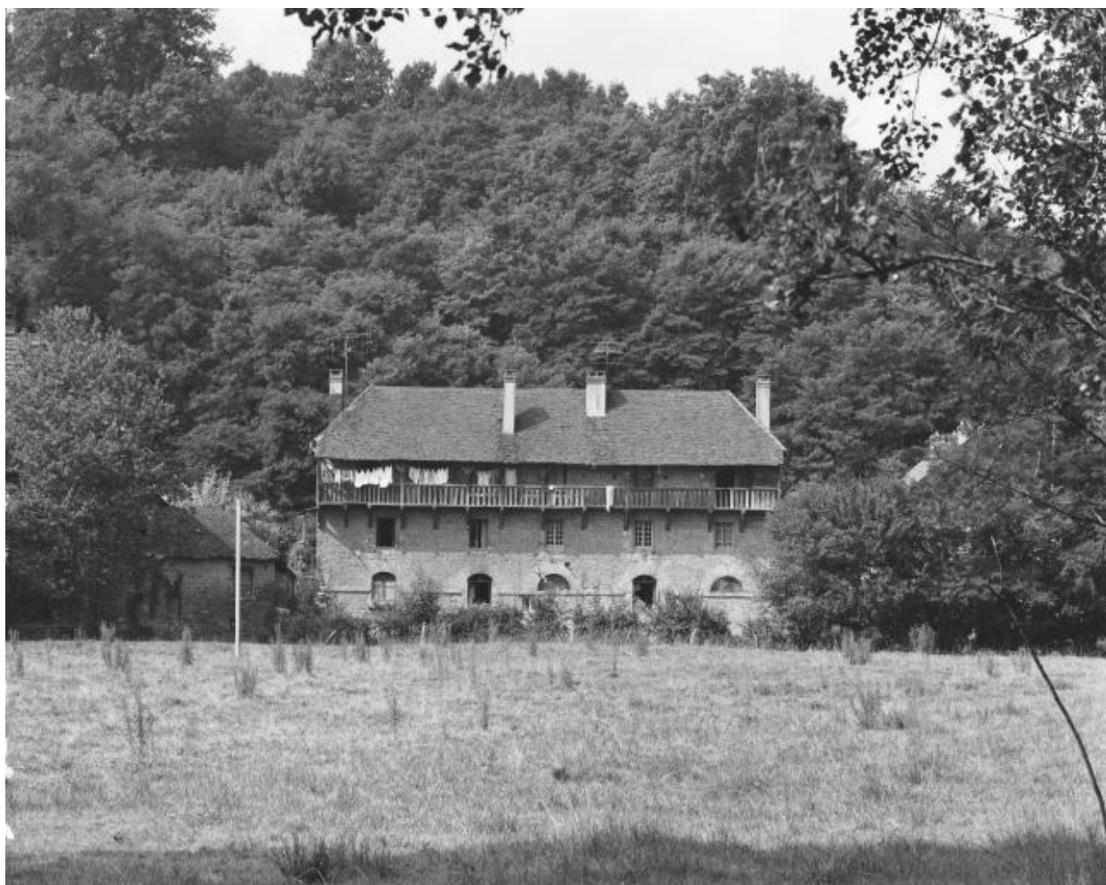
Façade postérieure d'un logement ouvrier.
