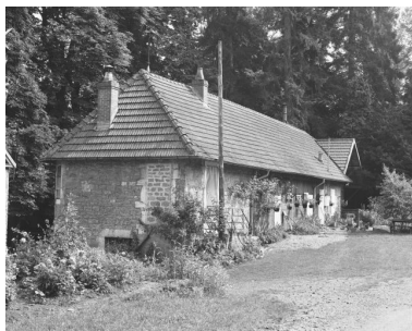
Logement ouvrier vu de trois quarts gauche. Phot. Dominique Dominguez IVR43_19803900286X
