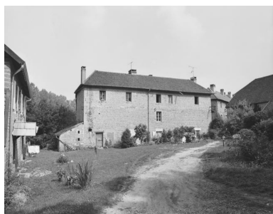
Logement d'ouvriers (C) en 1980. Façade postérieure vue depuis l'ouest. Phot. Dominique Dominguez IVR43_19803900277X
