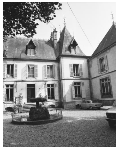
Vue partielle de la façade antérieure du château en 1980. Phot. Dominique Dominguez IVR43_19803900271X
