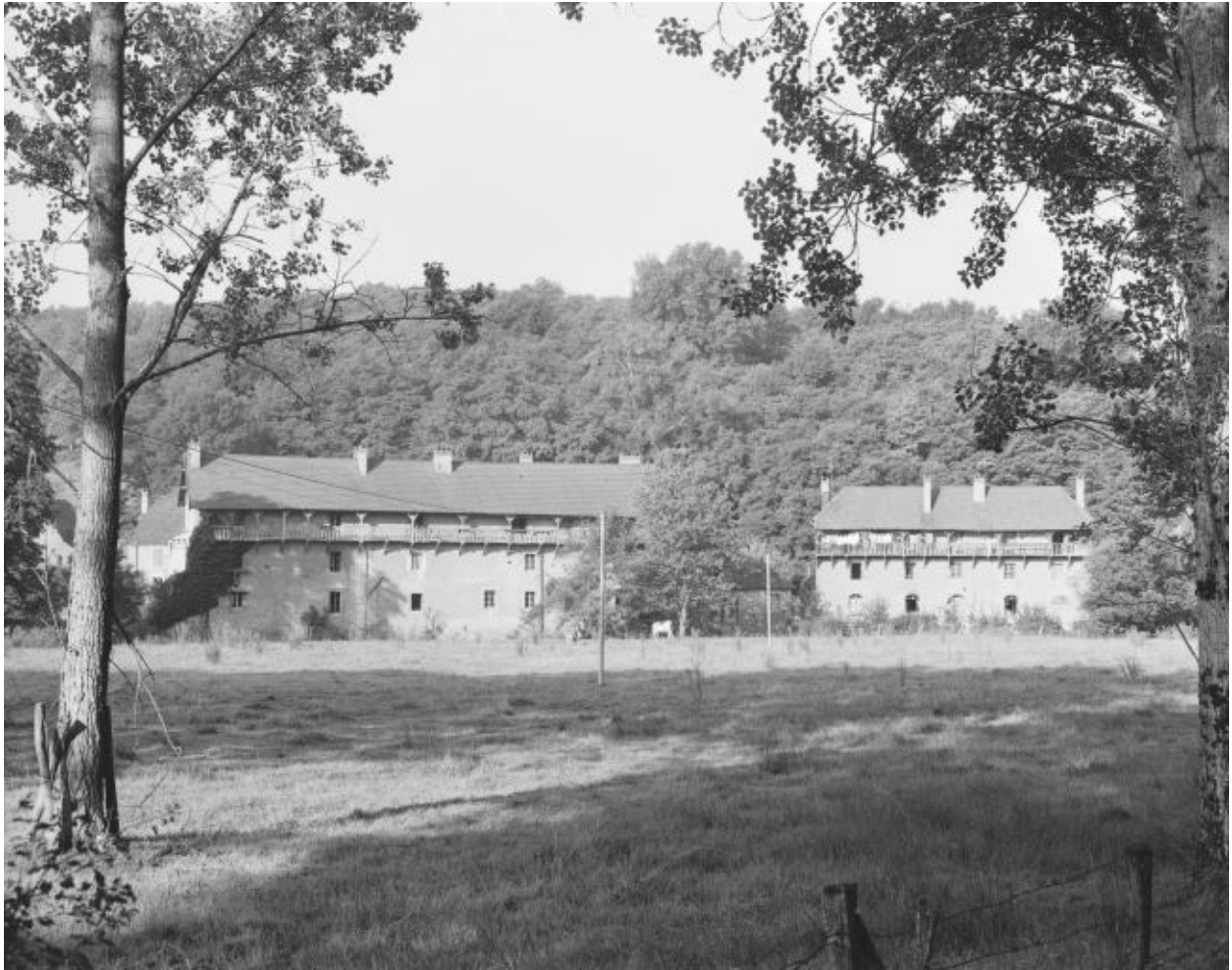
Façades postérieures des logements ouvriers.
