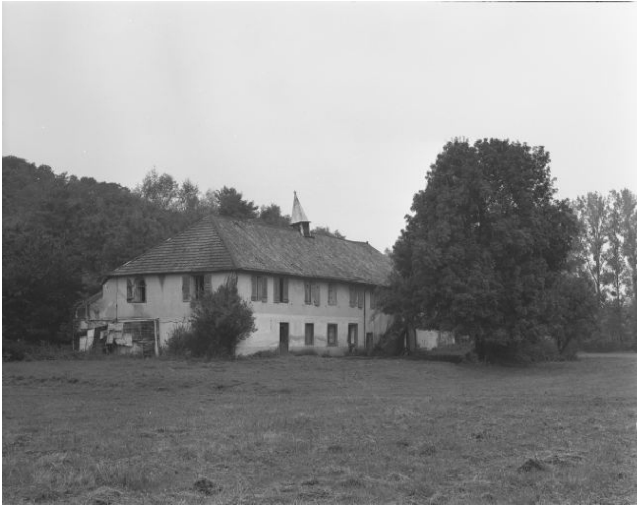
Le presbytère depuis le sud-est.
