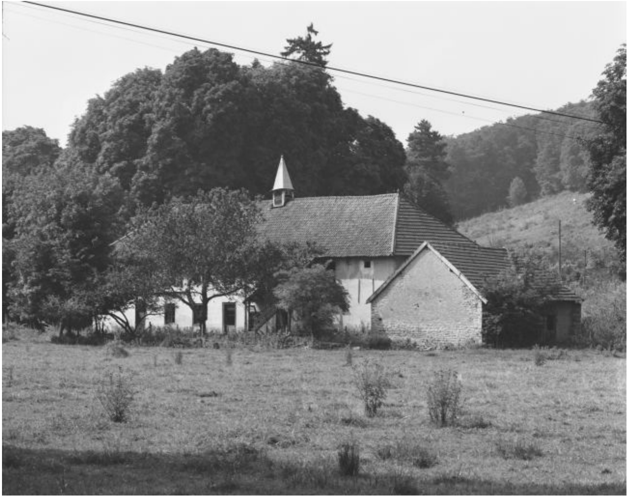
Façade postérieure du presbytère.
