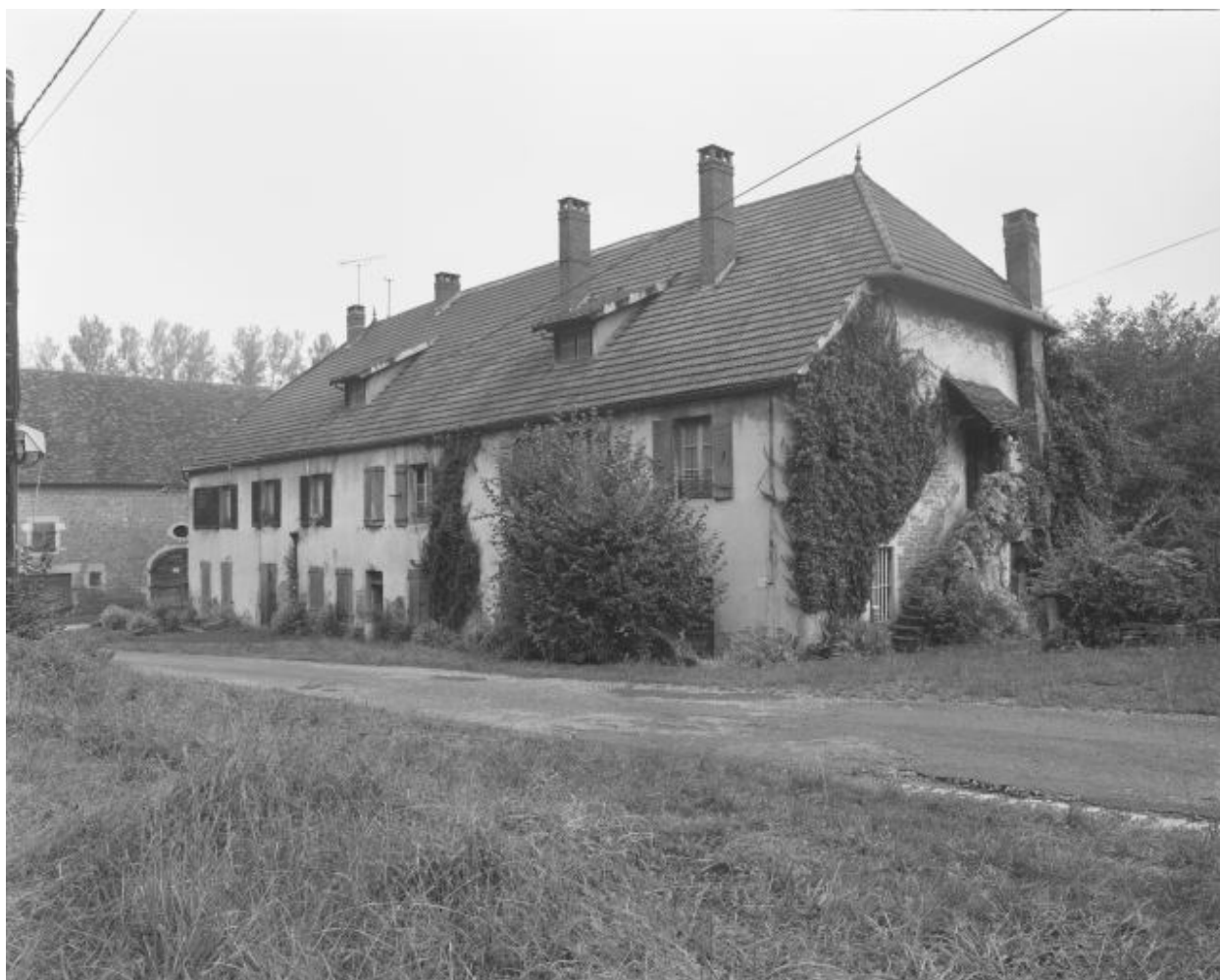
Logement patronal : façade antérieure vue depuis le sud-ouest.
