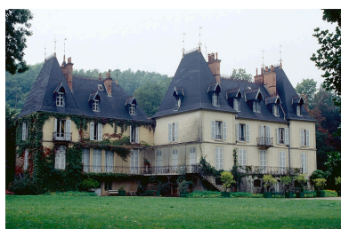
Façade postérieure du château vue depuis le sud-est. Phot. Jérôme Mongreville IVR43_19953900506ZA
