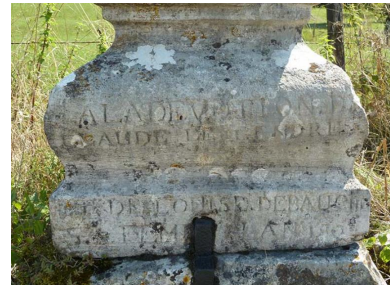
Détail du socle Phot. Sabrina Dalibard IVR43_20137000793NUC2A
