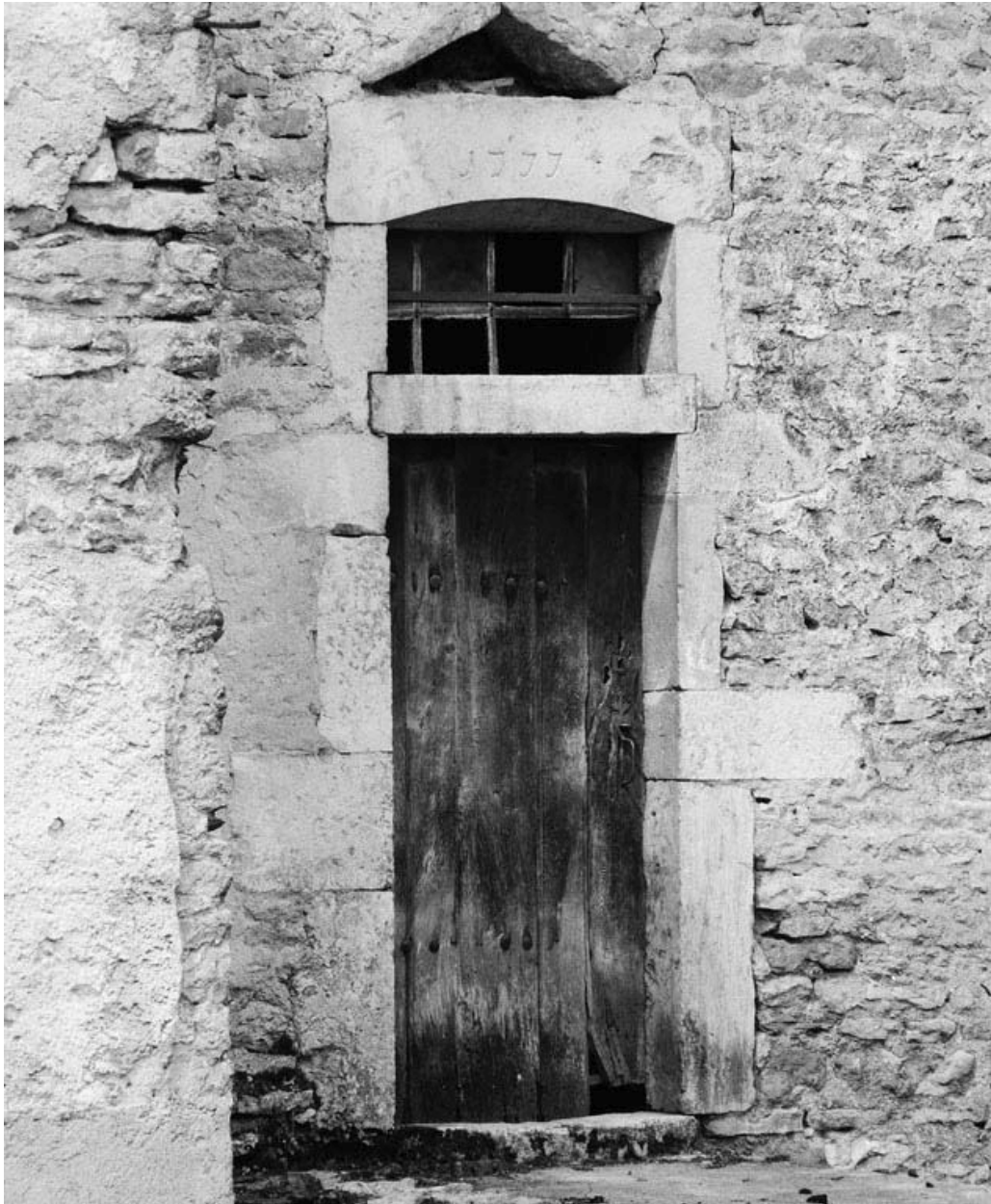
Détail de la porte.
