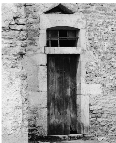
Détail de la porte. Phot. Jean-Luc Duthu IVR26_19802100395X
