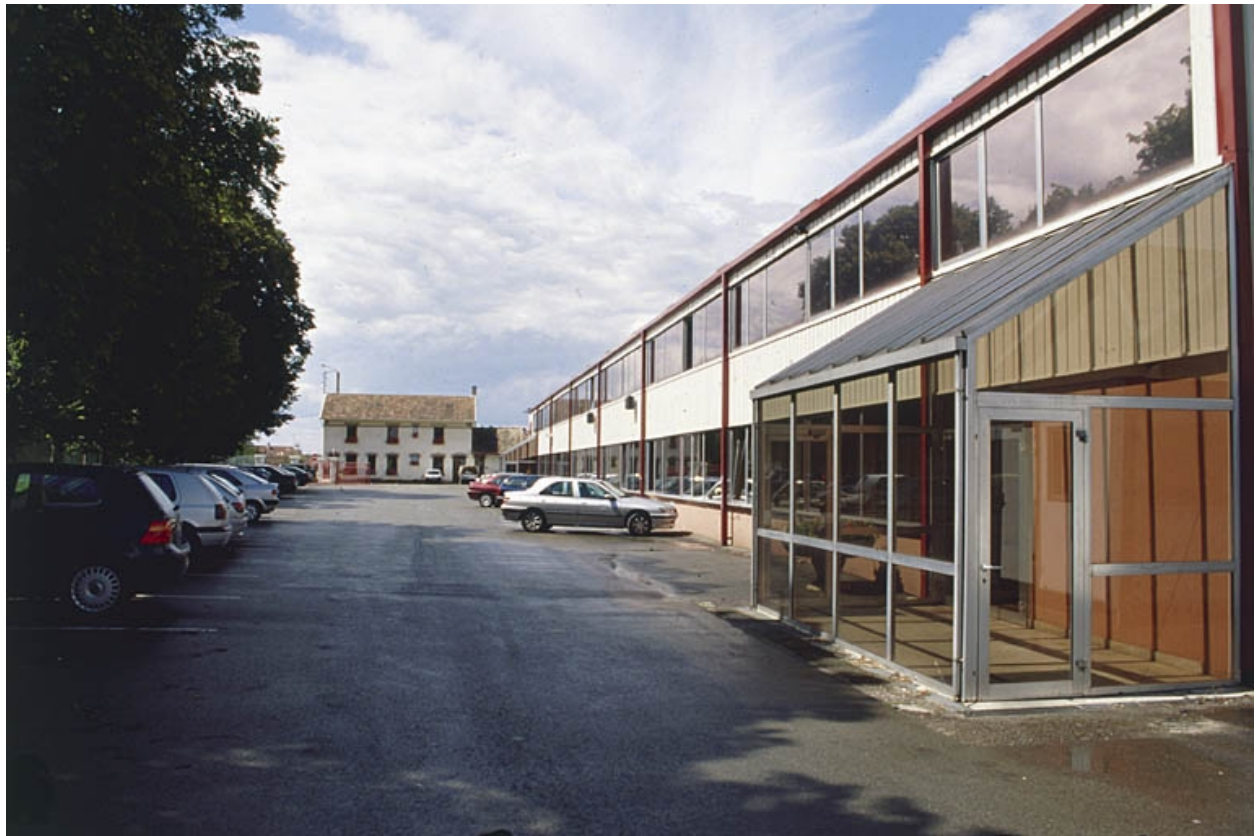
Conciergerie et alignement de la façade antérieure.
