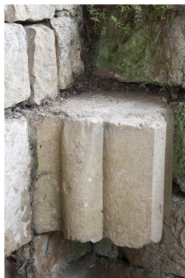
Elément architectural inséré dans le mur d'enclos. Phot. Jérôme Mongreville IVR43_20127000678NUC4A
