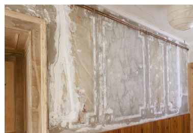
Le vestibule vu depuis l'entrée. Phot. Jérôme Mongreville IVR43_20127000688NUC4A
