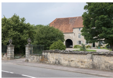
Vue générale depuis la rue Sadi Carnot. Phot. Jérôme Mongreville IVR43_20127000670NUC4A
