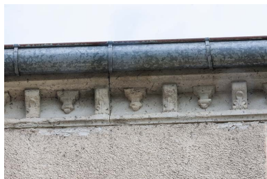
Détail de la corniche de la maison. Phot. Jérôme Mongreville IVR43_20127000682NUC4A
