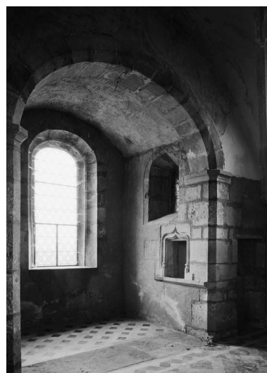
Chœur de la chapelle, vu de 3/4. Phot. Michel Rosso IVR26_19802100722V
