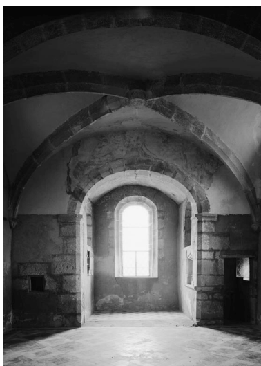
Deuxième travée de la nef de la chapelle et chœur. Phot. Michel Rosso IVR26_19802100723V
