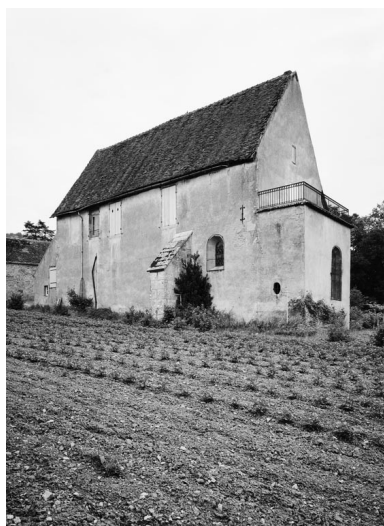
Elévation postérieure du bâtiment de la chapelle. Phot. Michel Rosso IVR26_19802100698V
