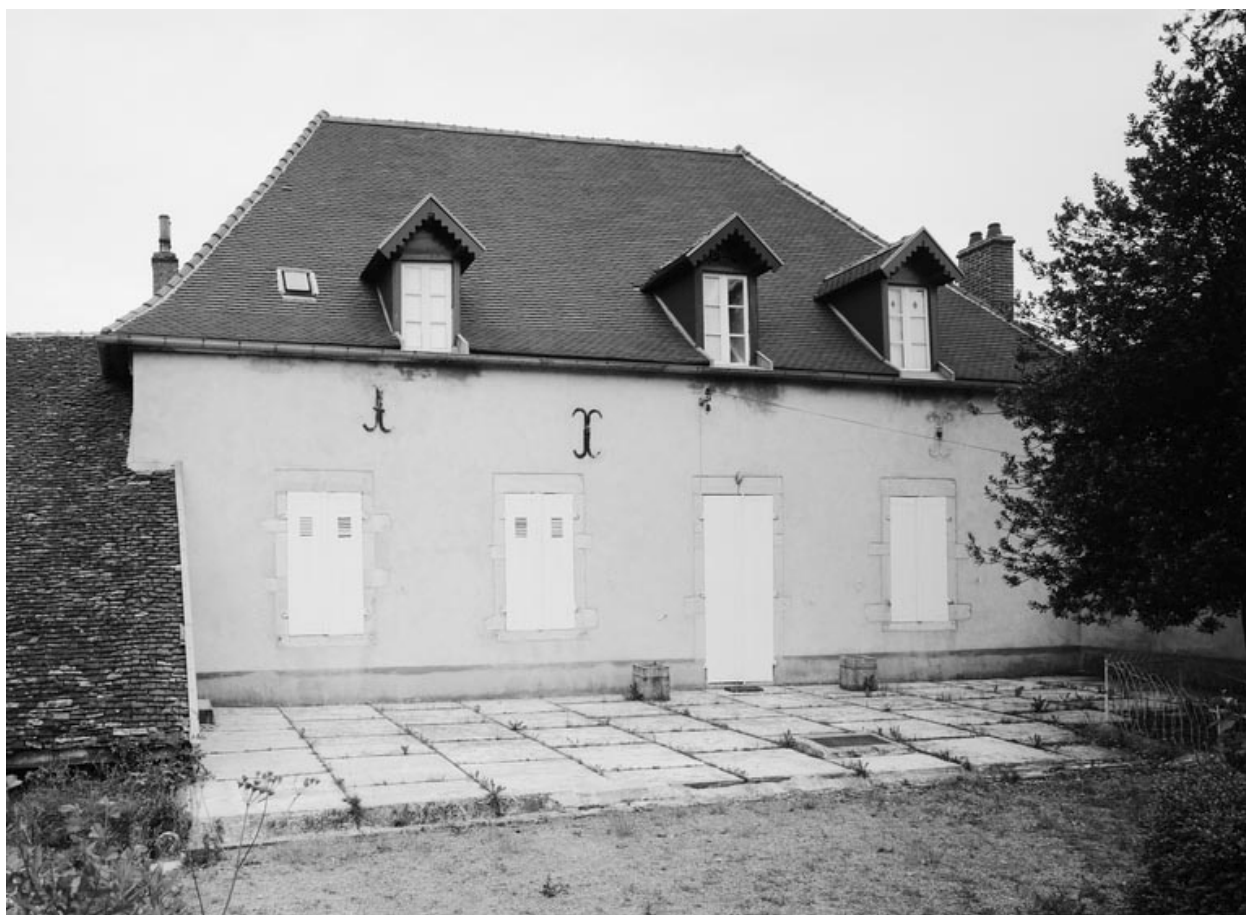
Façade postérieure du logis.
