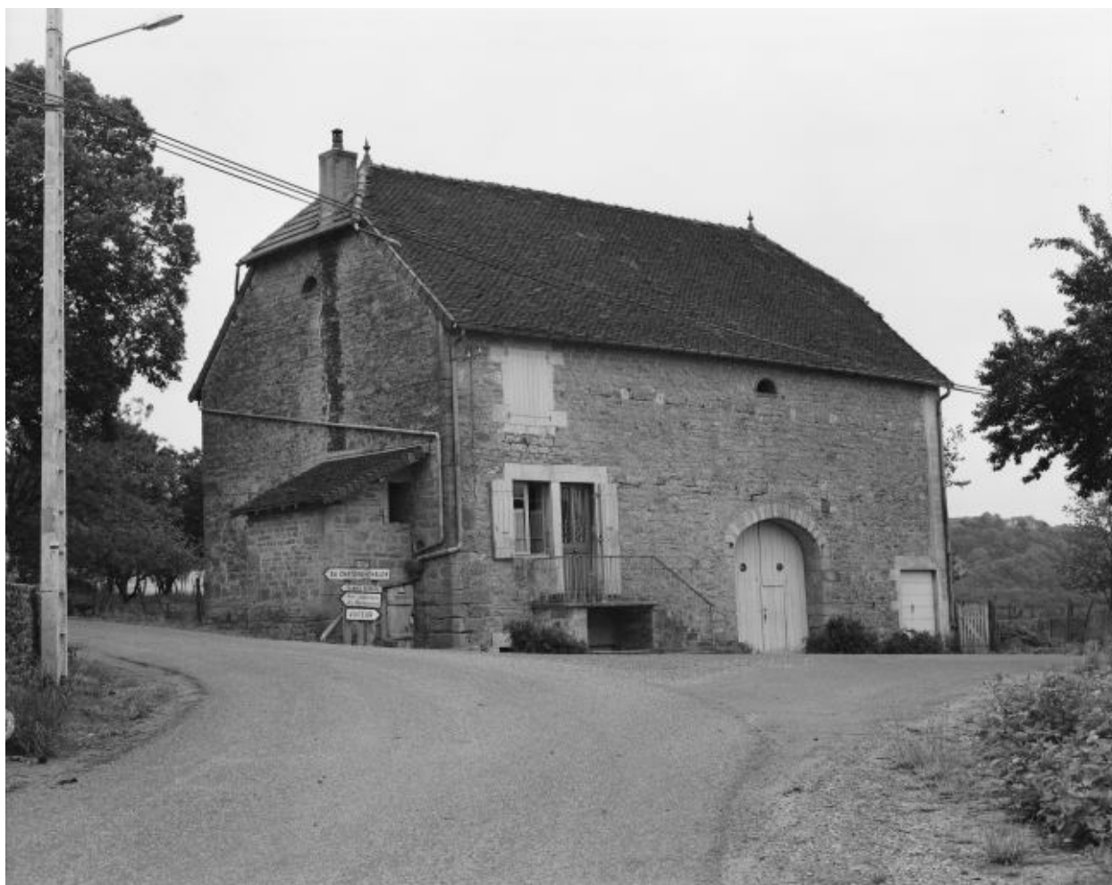
Ferme située route de Frontenay.
