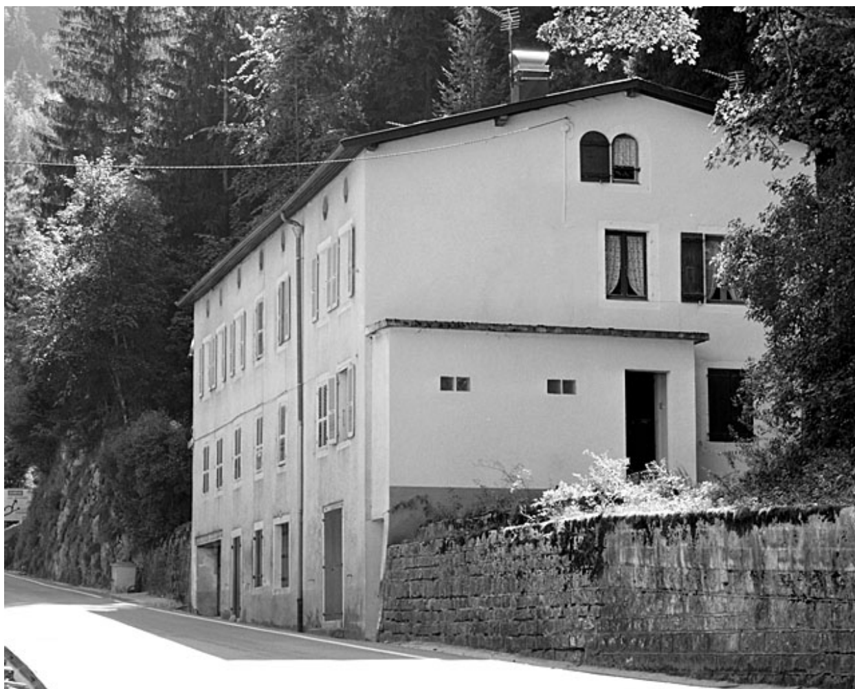
Façades antérieure et latérale droite.
