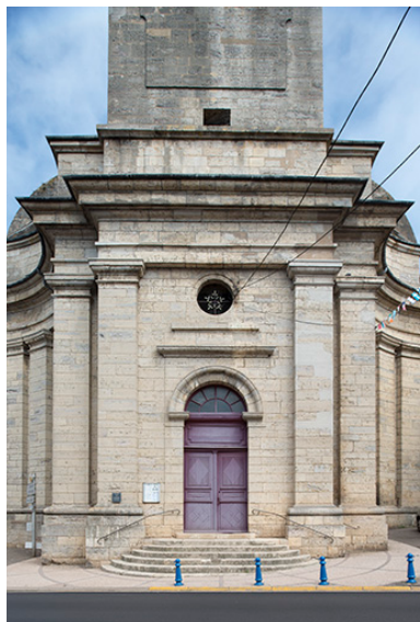
La façade principale et le portail d'entrée. Phot. Jérôme Mongreville IVR43_20177000980NUC4A
