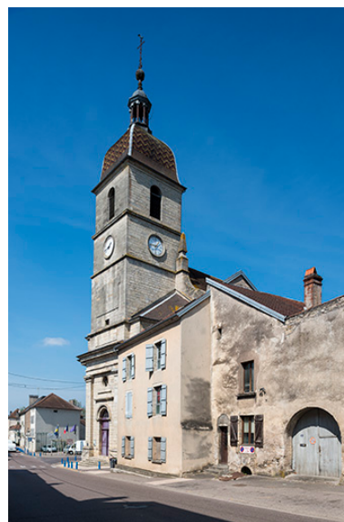
Le clocher carré et le toit à l'impérial. Phot. Jérôme Mongreville IVR43_20177000455NUC4A
