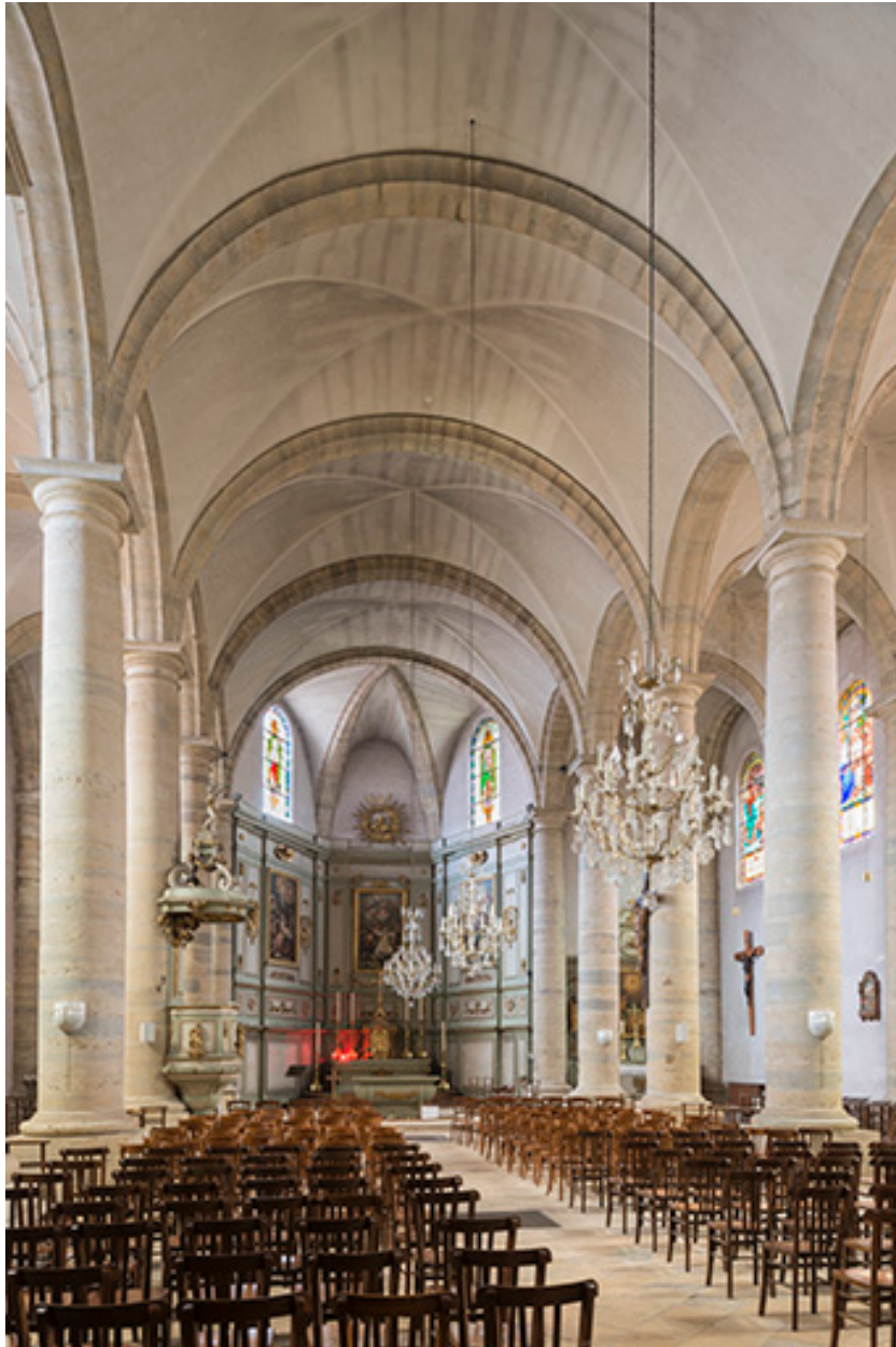
Vue générale de la nef centrale.
