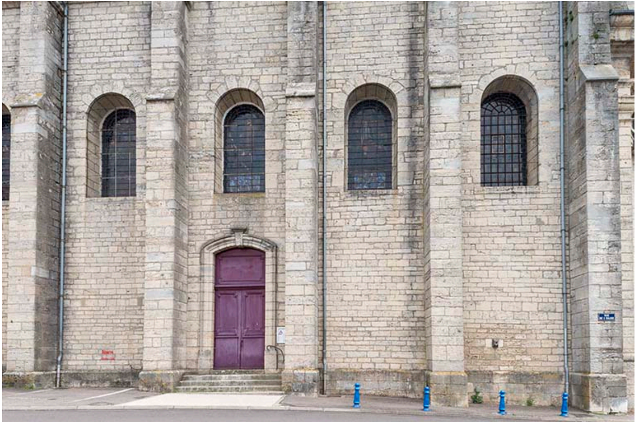
Le mur latéral ouest avec les baies en plein cintre.
