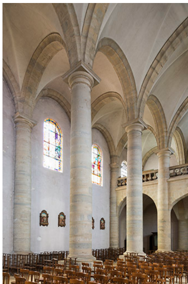
Vue sur les colonnes séparant la nef du collatéral Ouest. Phot. Jérôme Mongreville IVR43_20177000430NUC4A
