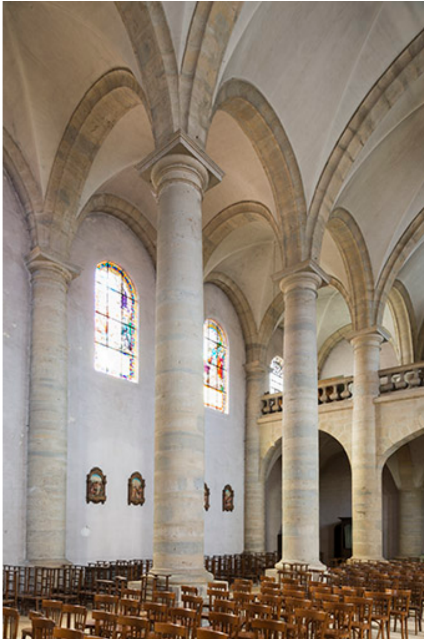
Vue sur les colonnes séparant la nef du collatéral Ouest.
