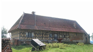
Vue d'ensemble de la façade.
