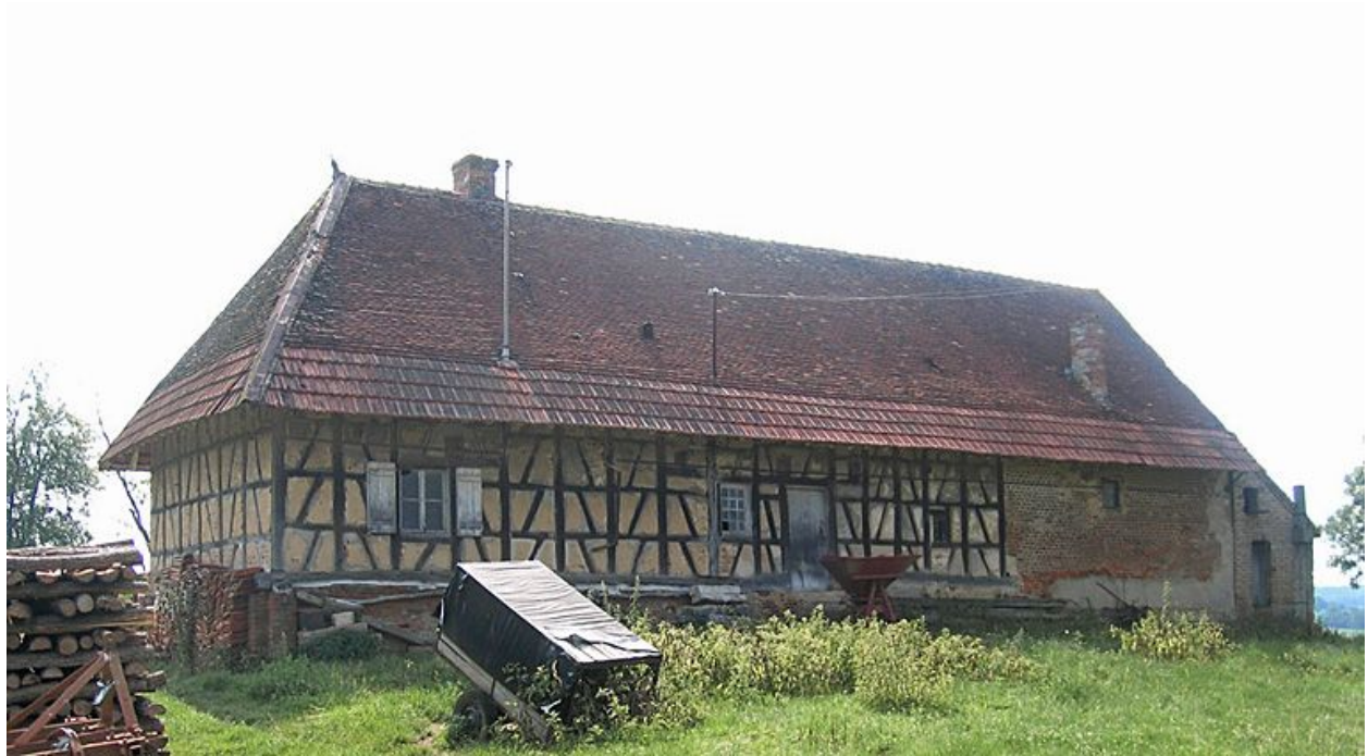
Vue d'ensemble de la façade.
