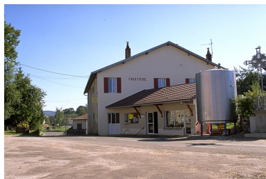
Vue d'ensemble. Phot. Yves Sancey IVR43_19973901300ZA
