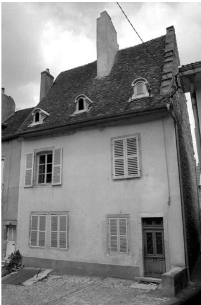
Façade antérieure de l'habitation sur rue Saint-Hilaire.
