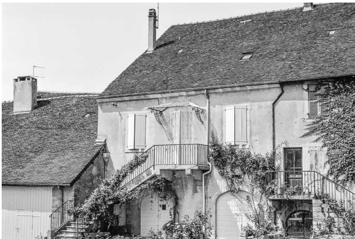
Façade antérieure : vue rapprochée.
