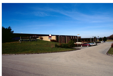
Chaufferie, quai d'expédition et bureaux depuis l'entrée. Phot. Yves Sancey IVR43_19973900434ZA
