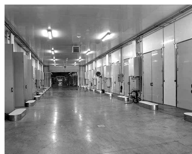
Couloir central des pièces d'affinage. Phot. Yves Sancey IVR43_19963901927X
