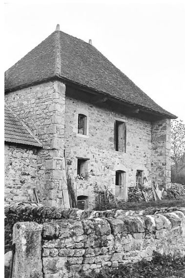
Maison, anciennement à galerie ou à balcon, à Frâgne, vers 1970. Phot. Raymond Oursel IVR26_20207100088NUC2
