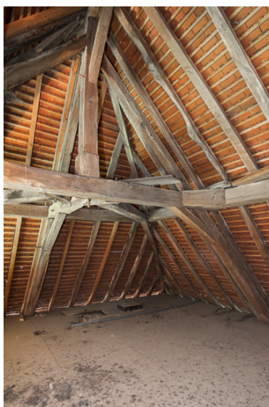
Vue de la charpente du toit à croupes de la maison Phot. Pierre-Marie Barbe-Richaud IVR26_20197100293NUC4A
