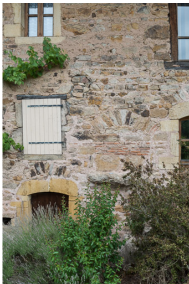
Détail de la façade antérieure de la maison. Au centre, l'évacuation de la pierre d'évier. Phot. Pierre-Marie Barbe-Richaud IVR26_20197100288NUC4A
