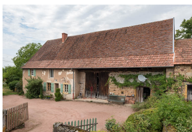
Vue des bâtiments inscrits dans le même alignement, à la suite des précédents. La grange était autrefois constitué d'une remise et de deux étables de part et d'autre. Celle de gauche a été par la suite incluse dans l'espace de la seconde maison, construite au milieu du XVIIIe siècle et remaniée vers 1840. Phot. Pierre-Marie Barbe-Richaud IVR26_20197100294NUC4A
