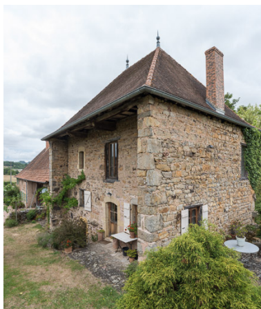
Vue d'ensemble de l'alignement. Au premier plan, la maison d'origine, construite dans le premier quart du XVIIIe siècle. Phot. Pierre-Marie Barbe-Richaud IVR26_20197100287NUC4AQ
