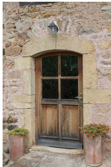
Porte d'entrée de la maison, couverte d'un arc segmentaire Phot. Pierre-Marie Barbe-Richaud IVR26_20197100289NUC4A
