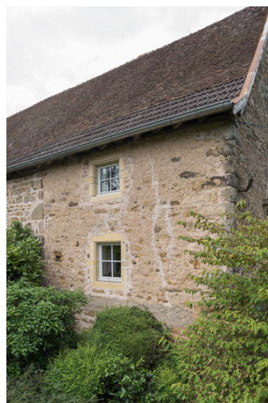
Vue de la façade postérieure de la maison. La rupture de maçonnerie montre qu'il s'agit bien d'un agrandissement de la grange primitive vers l'ouest. Phot. Pierre-Marie Barbe-Richaud IVR26_20197100283NUC4A
