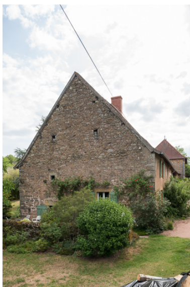
Vue du pignon de la seconde maison Phot. Pierre-Marie Barbe-Richaud IVR26_20197100282NUC4A
