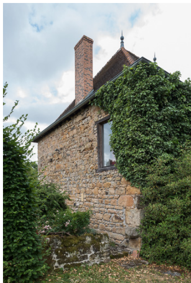
Vue de l'angle sud-est de la maison. Les traces d'arrachement de mur indique l'emplacement de l'ancien escalier qui permettait l'accès à l'étage. Phot. Pierre-Marie Barbe-Richaud IVR26_20197100285NUC4A
