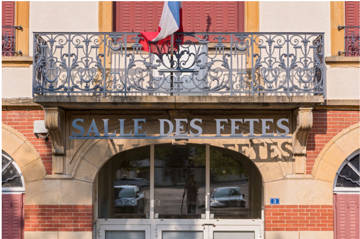
Façade antérieure : enseigne et balcon.
