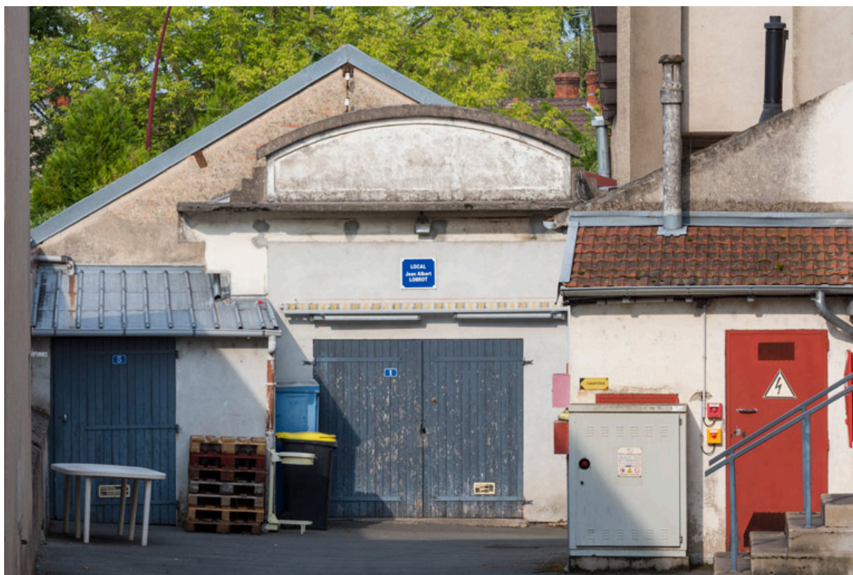
Garage en fond de cour, au nord-est.
