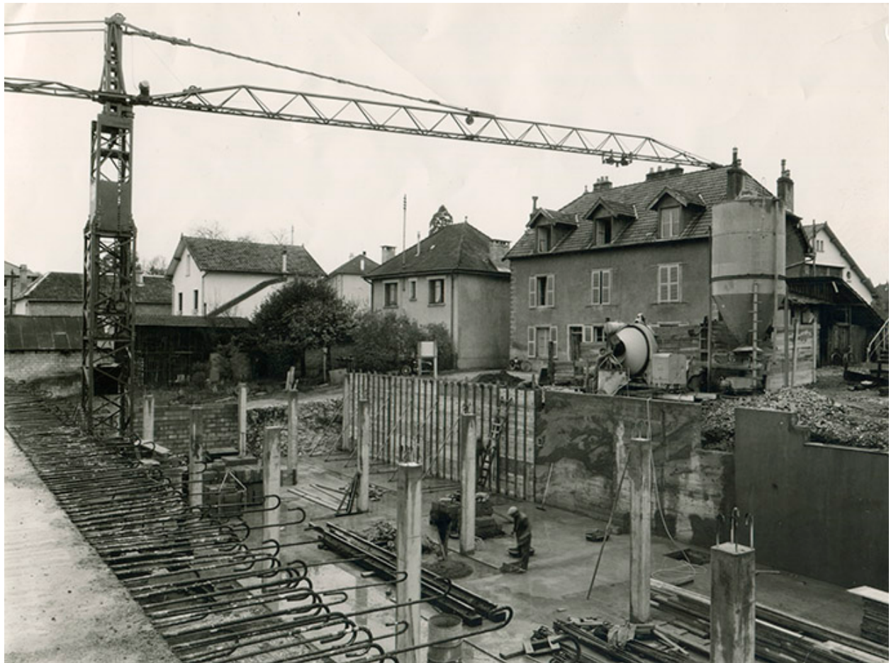
Chantier de construction de l'usine B, fotogr., 1961.
