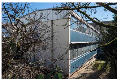
Extension nord, vue de trois quarts. Phot. Jérôme Mongreville IVR43_20182500566NUC4A
