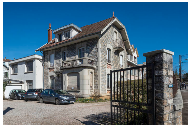
Le logement vu de trois quarts gauche. Phot. Jérôme Mongreville IVR43_20182500564NUC4A
