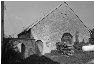
Vue générale des parties agricoles. Phot. Gilbert Poinot IVR43_19762500909Z
