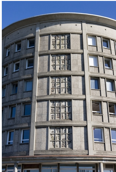
Détail de la tour : la verrière. Phot. Yves Sancey IVR43_20072501015NUCA
