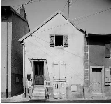
Façade antérieure de face.
