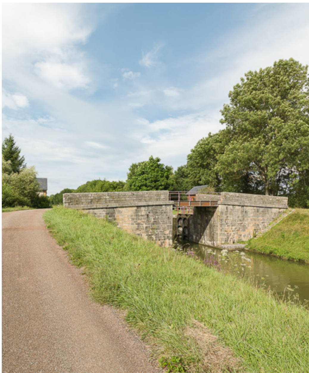
Vue d'ensemble du pont.
