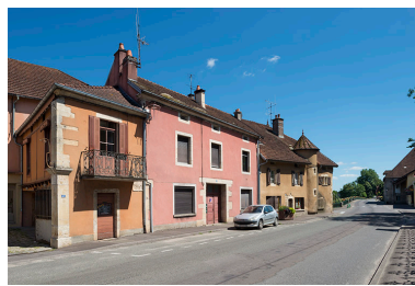
Extrémité sud de la rue Armand Paulmard, en direction du pont sur la Saône. Phot. Jérôme Mongreville IVR43_20187000452NUC4A
