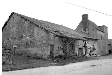
Vue générale depuis la rue. Phot. Yves Sancey IVR43_19802500892X
