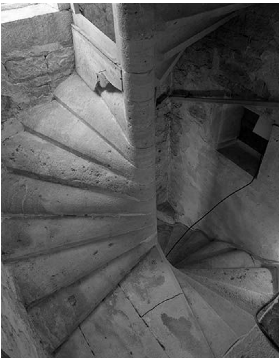
Intérieur : l'escalier en vis.
