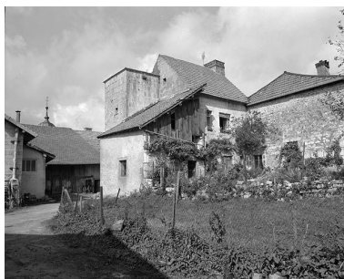
Vue générale depuis le jardin. Phot. Yves Sancey IVR43_19802500893X
