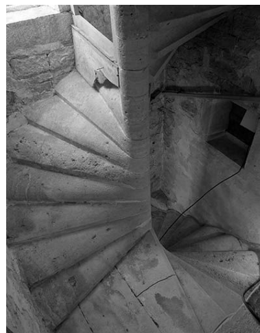
Intérieur : l'escalier en vis. Phot. Yves Sancey IVR43_19802500894X
