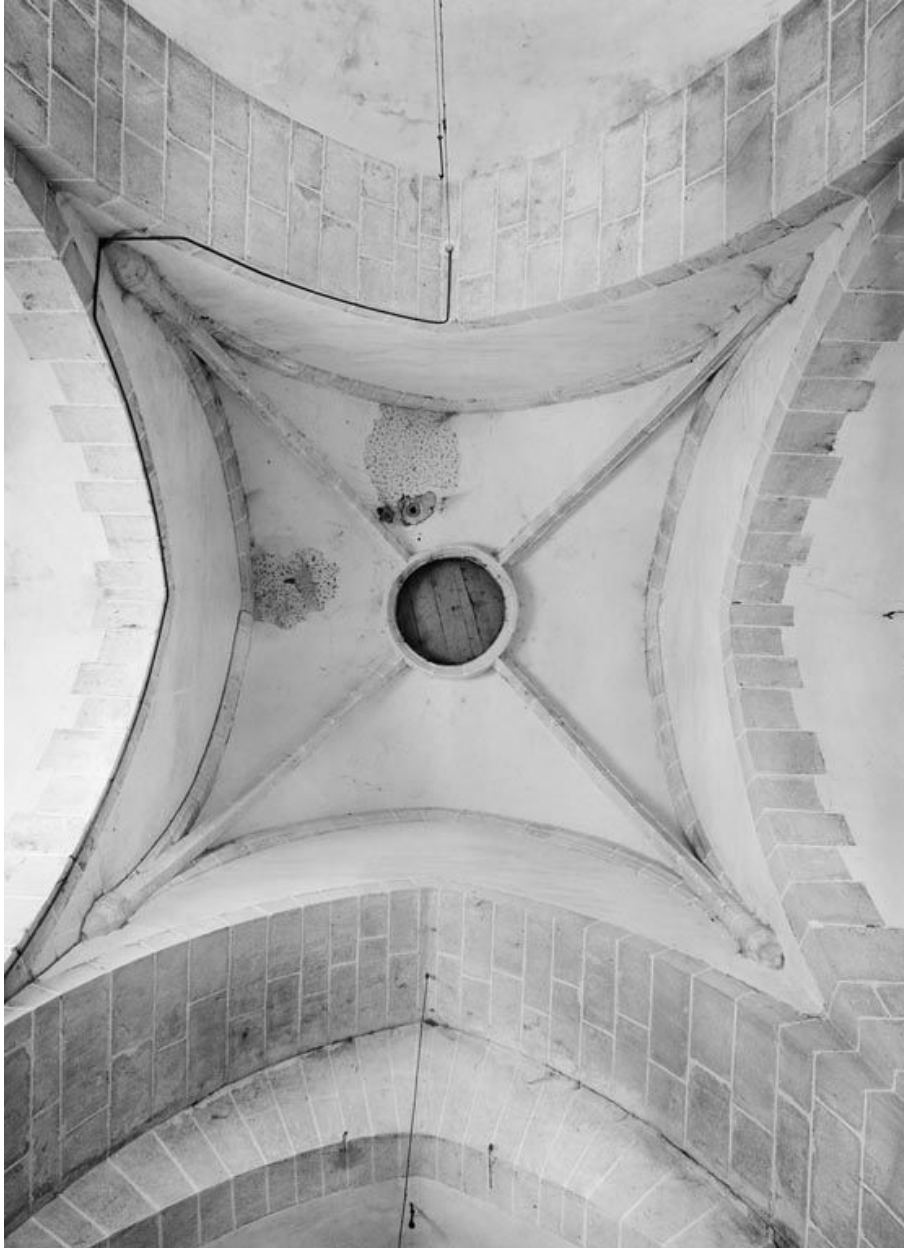
La voûte de la travée sous clocher.
