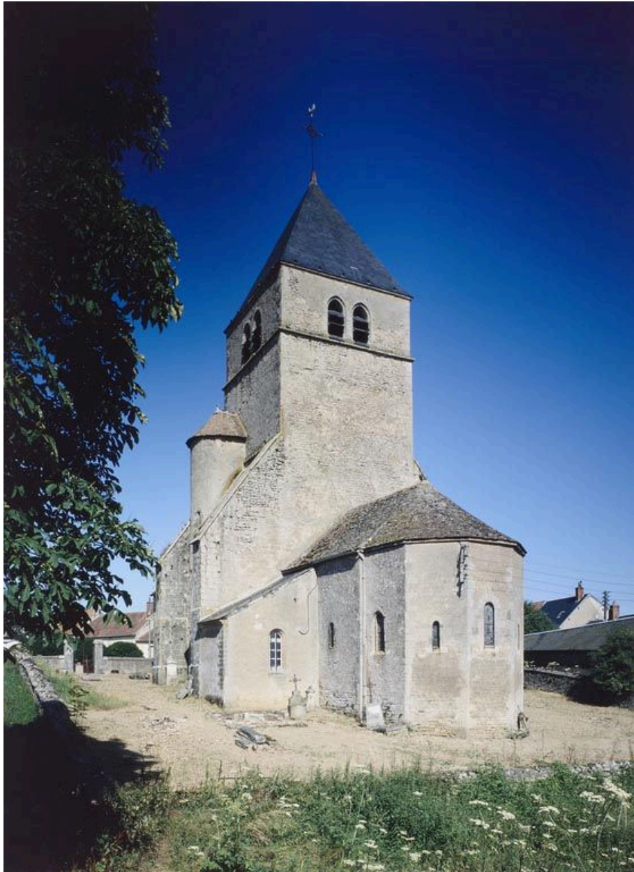
Vue d'ensemble depuis le chevet.
