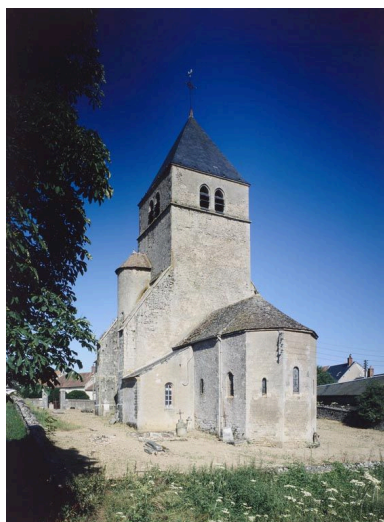
Vue d'ensemble depuis le chevet. Phot. Michel Thierry IVR26_19825800067VA
