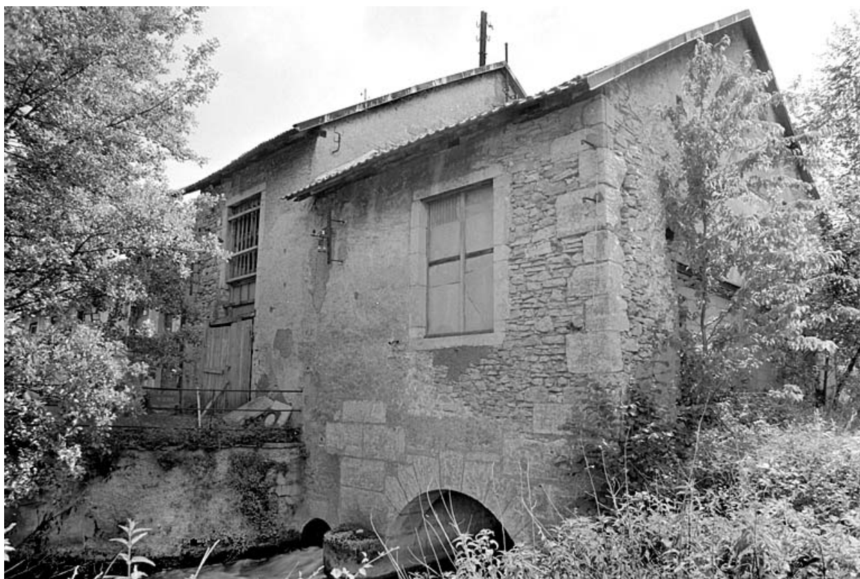
Salle des machines et bâtiment d'eau.
