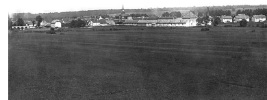
L'usine du Château depuis le sud. Phot. Jérôme Mongreville, Autr. L. (photographe) Edmond IVR43_20009000004X
