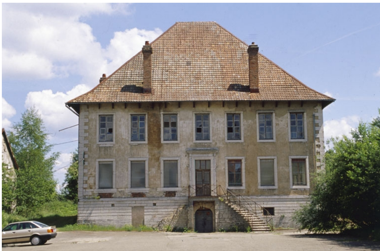
Façade antérieure du château.
