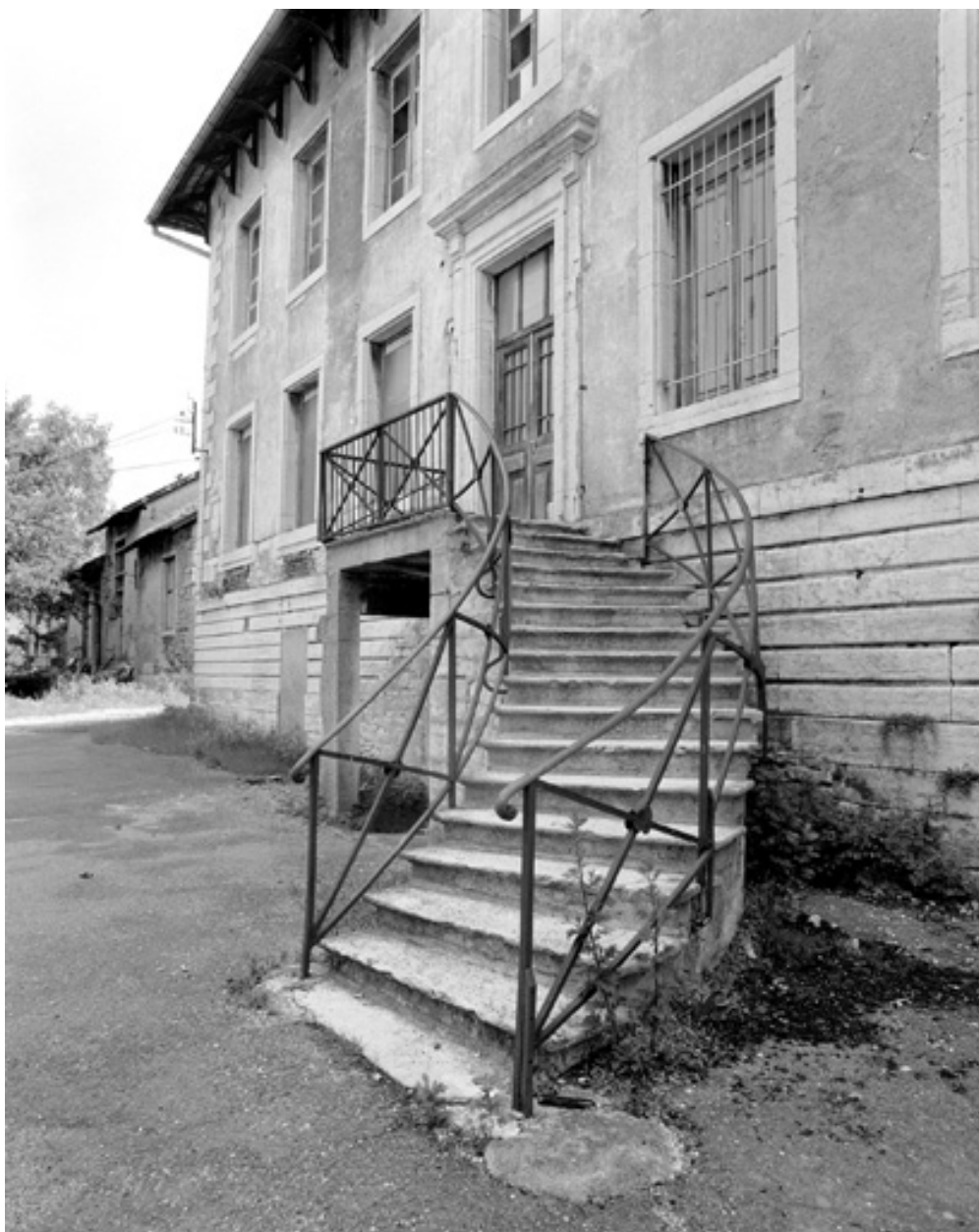
Volée droite de l'escalier.
