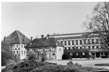
L'usine du Château en 1983. Phot. Jérôme Mongreville, Autr. Courvoisier IVR43_20009000003X
