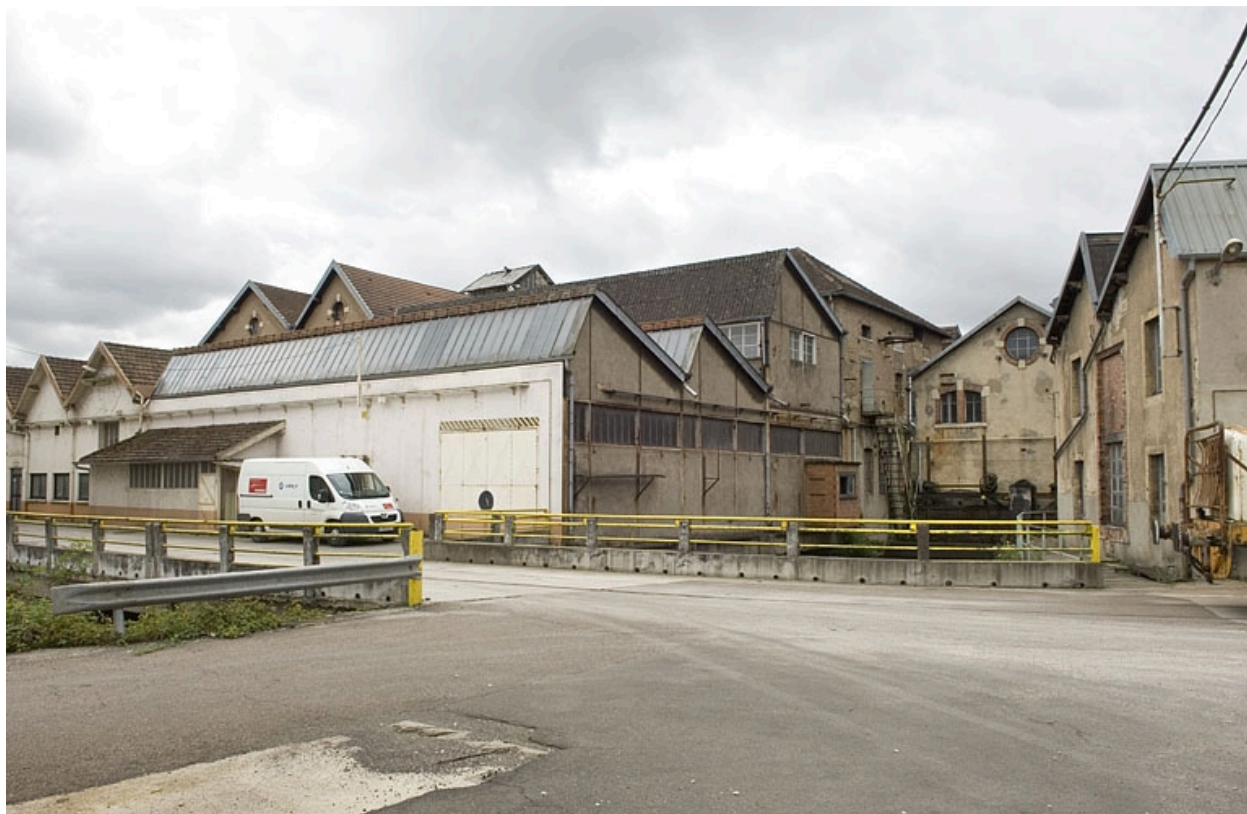
Atelier de fabrication (papeterie) et bâtiment d'eau.
