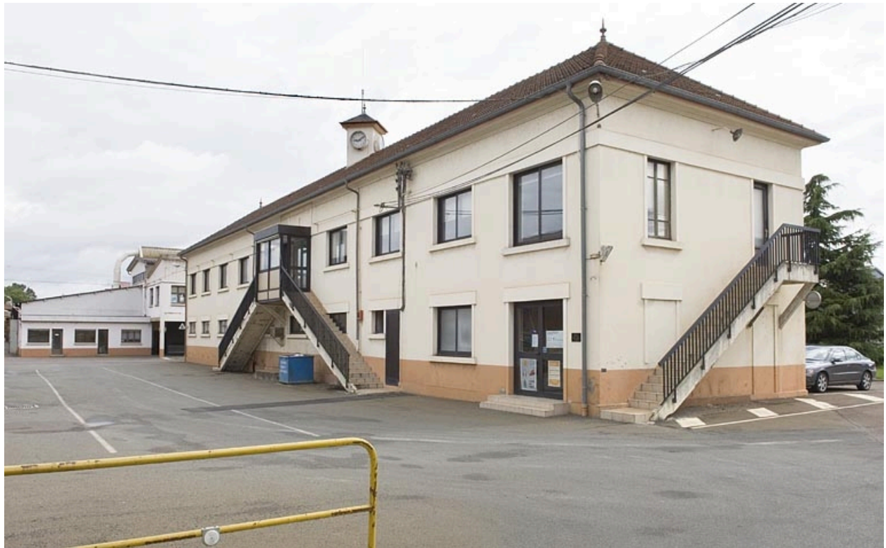
Bureaux. Vue de trois quarts arrière.
