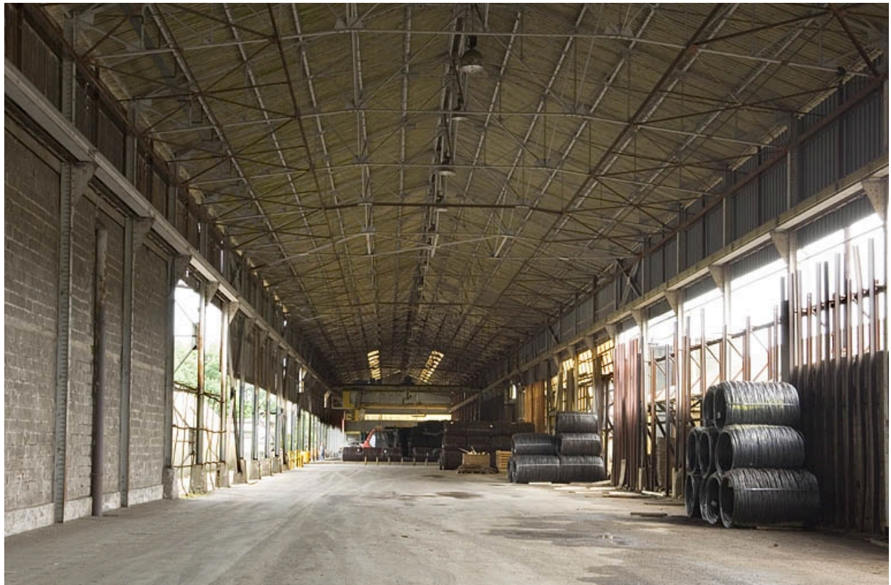
Vue intérieure d'un entrepôt industriel.
