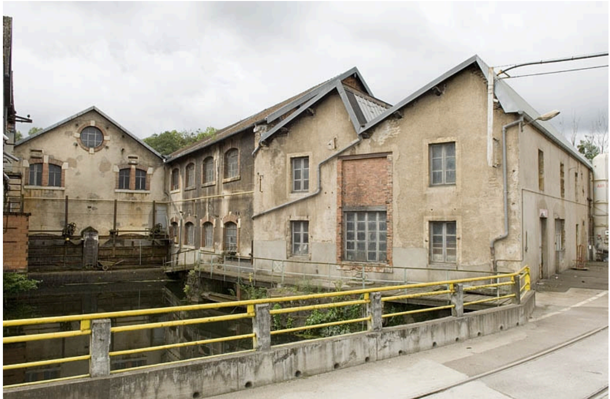
Bief d'amenée, bâtiment d'eau et atelier.
