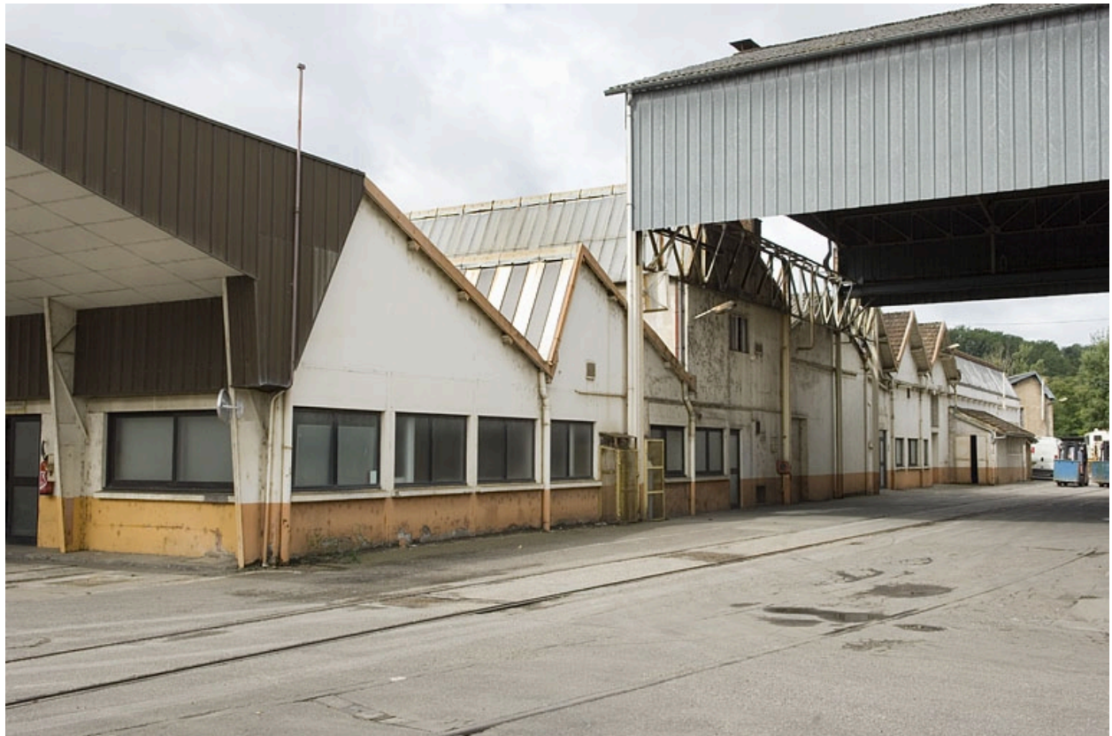
Façades nord des ateliers de fabrication.
