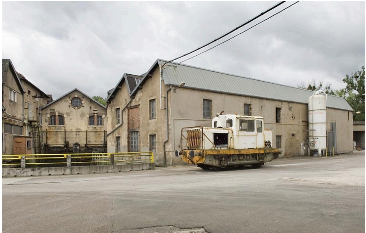
Bâtiment d'eau et atelier couvert de sheds.
