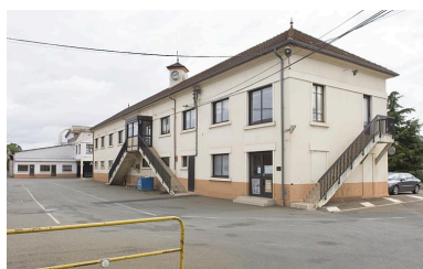
Bureaux. Vue de trois quarts arrière.
