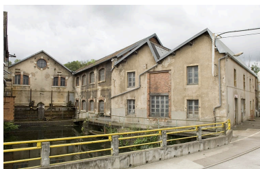
Bief d'amenée, bâtiment
