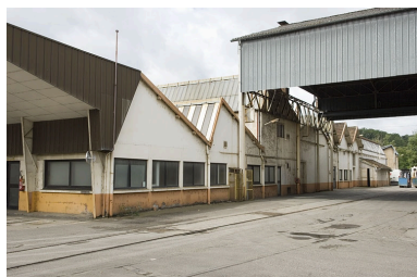
Façades nord des
