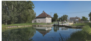
Vue d'amont. Phot. Thierry Kuntz IVR26_20112103133NUC4A
