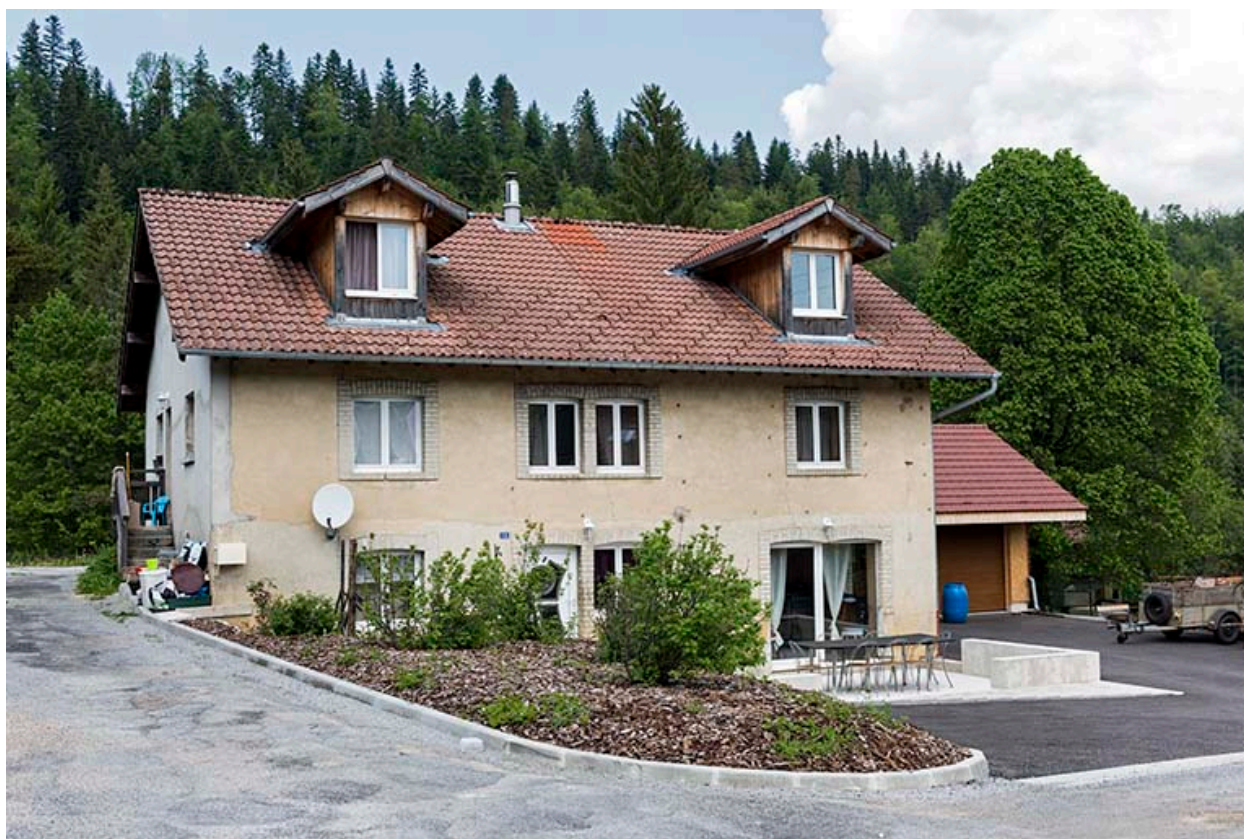
La maison : vue d'ensemble.
