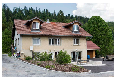
La maison : vue d'ensemble.
