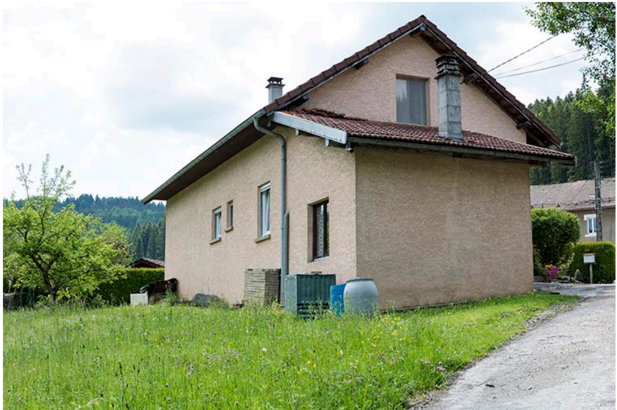
L'atelier : façades postérieure et latérale gauche.
