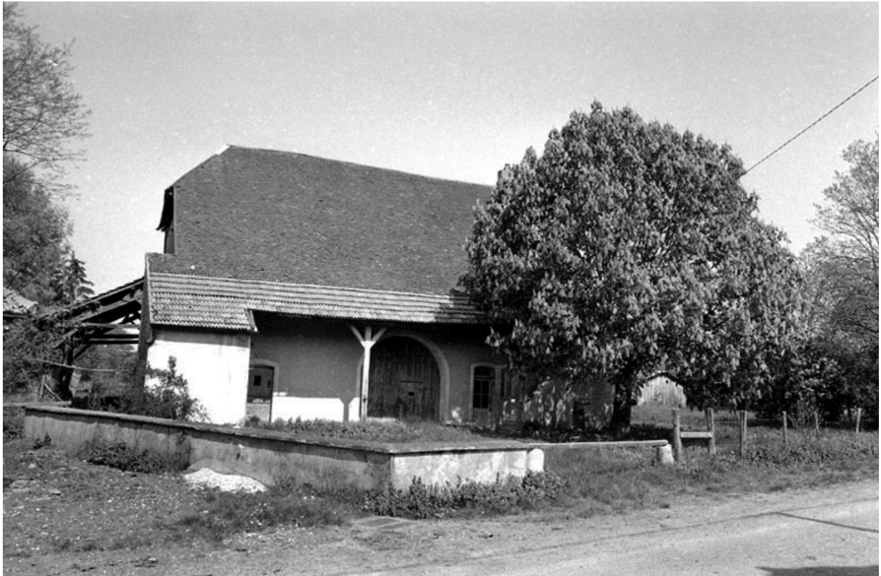
Vue d'ensemble depuis la rue.
