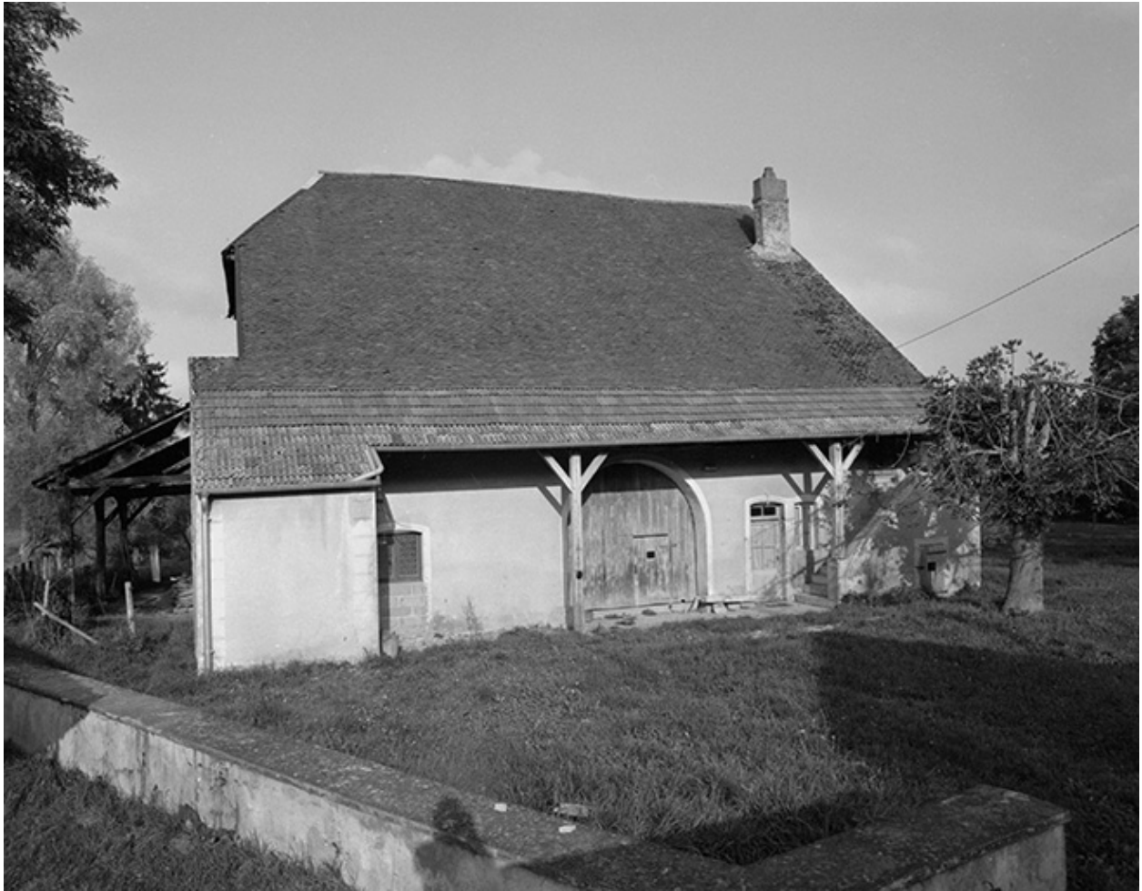
Vue d'ensemble depuis la rue.
