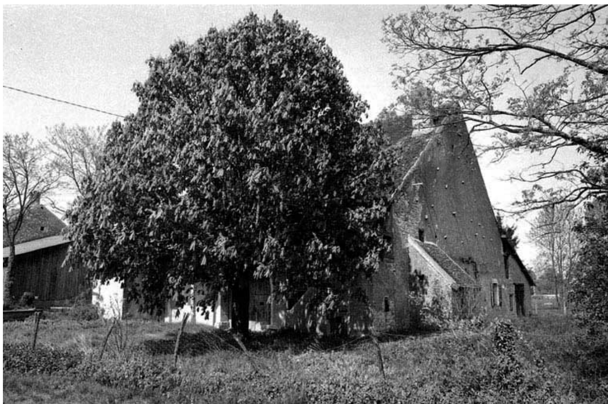
Façade latérale droite.
