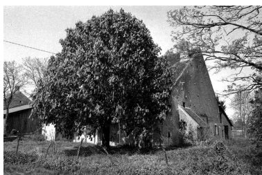
Façade latérale droite. Phot. Bernard Lardière IVR43_19817000352Z
