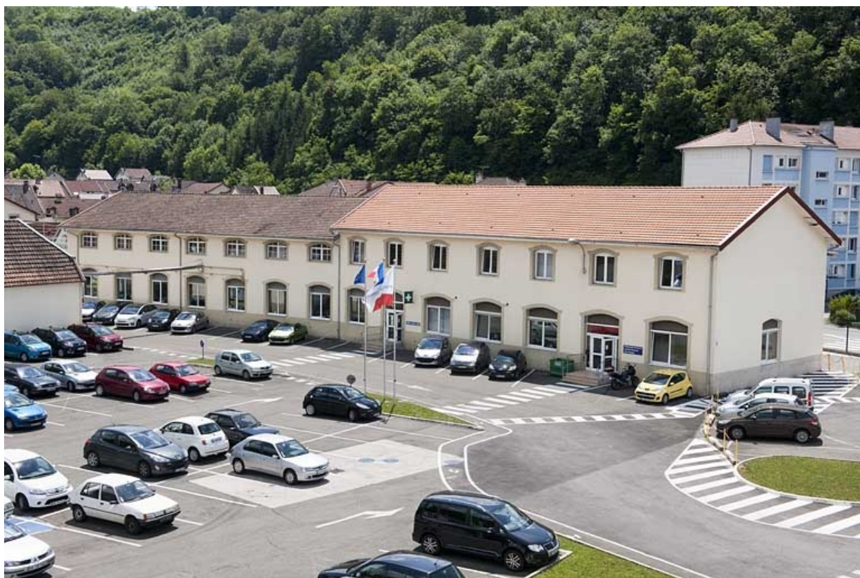
Bâtiment des bureaux depuis le nord-est.
