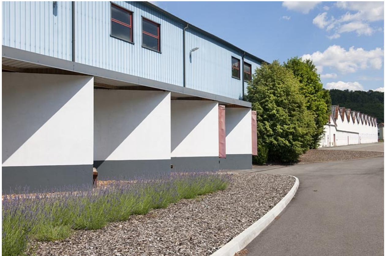
Magasin de stockage des véhicules et entrepôts industriels.
