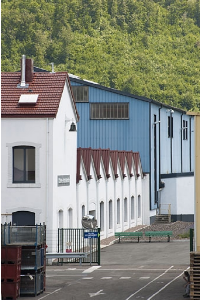
Vue en enfilade des bâtiments sud.
