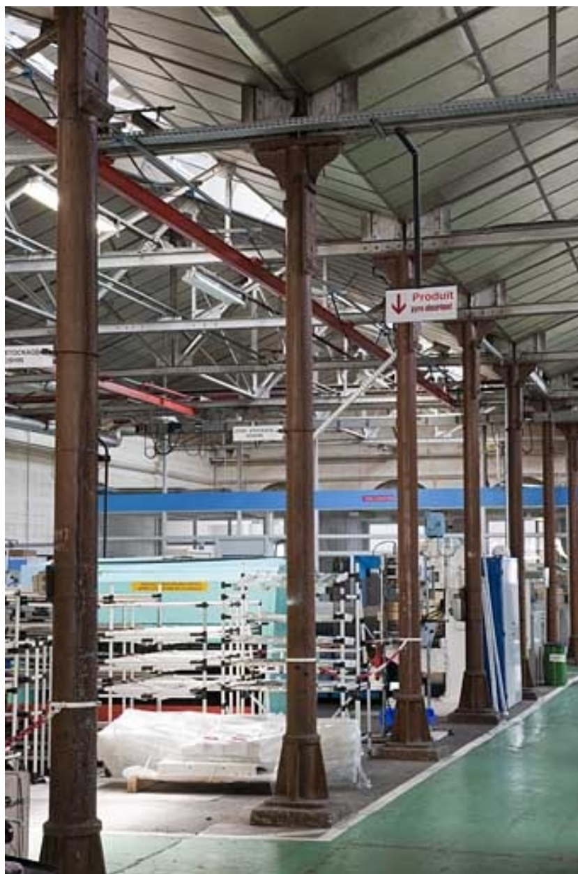
Atelier de fabrication (aujourd'hui de maintenance).
