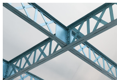
Centre d'archives. Poutrelles à treillis de la charpente. Phot. Jérôme Mongreville IVR43_20112501372NUC4A
