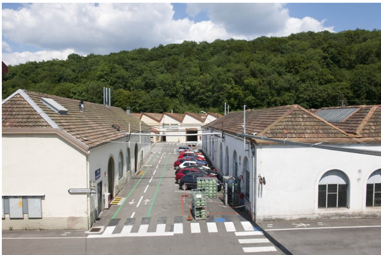
Magasin industriel et atelier de maintenance.
