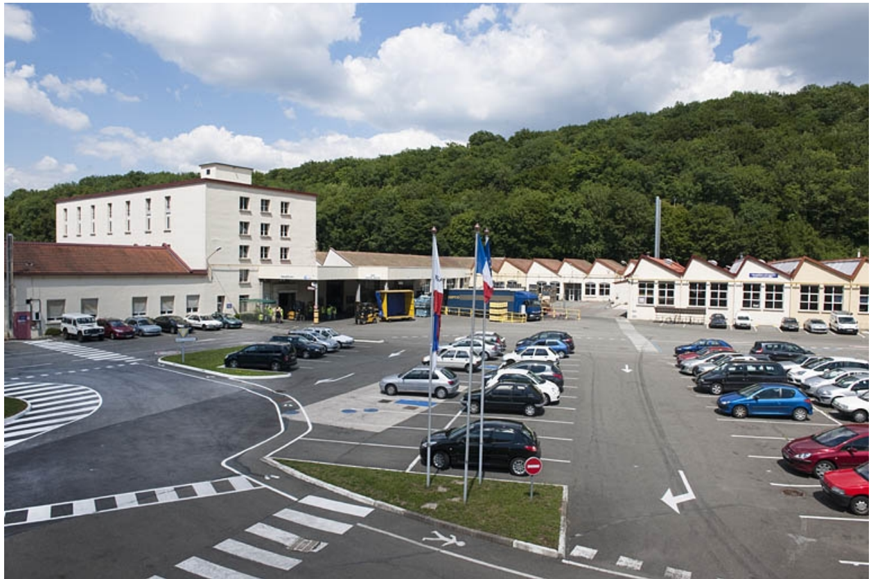
Vue d'ensemble depuis le bâtiment des bureaux.
