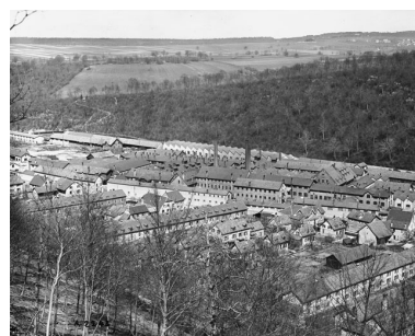
Cités ouvrières et usine depuis le sud. Photogr., s.n., s.d. [vers 1900]. Autr. IVR43_20122501592NUC2
