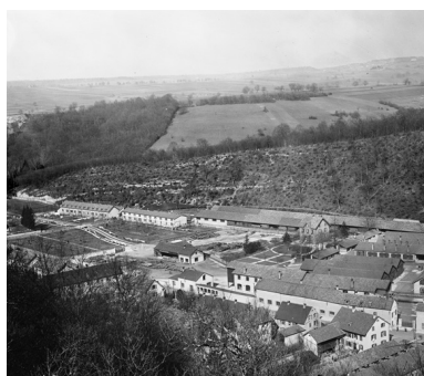
Extrémité nord de l'usine. Photogr., s.n., s.d. [vers 1900]. Autr. IVR43_20122501591NUC2
