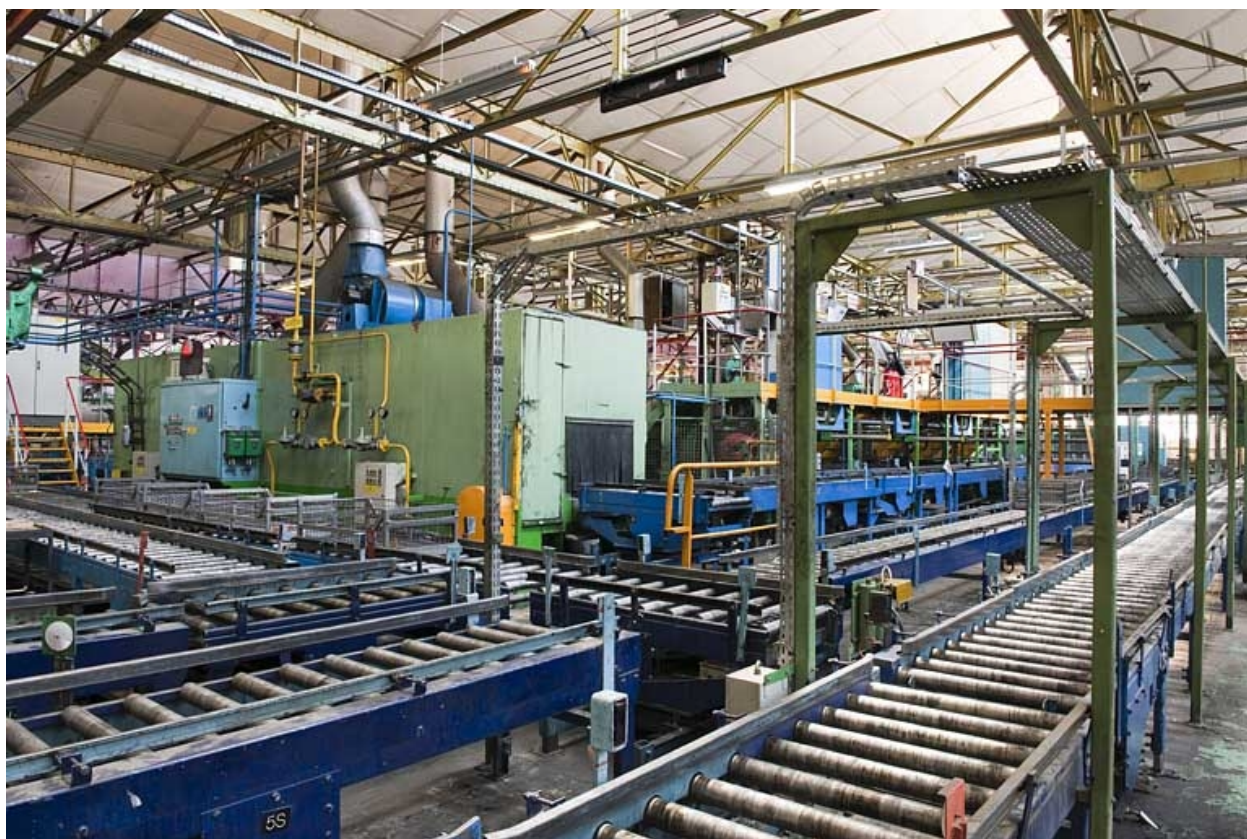
Atelier de rénovation des moteurs. Chaîne désaffectée.
