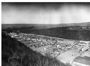
Vue générale depuis le sud. Photogr., s.n., s.d. [vers 1900]. Autr. IVR43_20122501588NUC2
