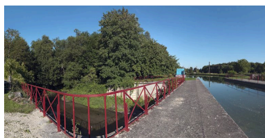
Sur le pont canal. Phot. Thierry Kuntz IVR26_20118900118NUC4A
