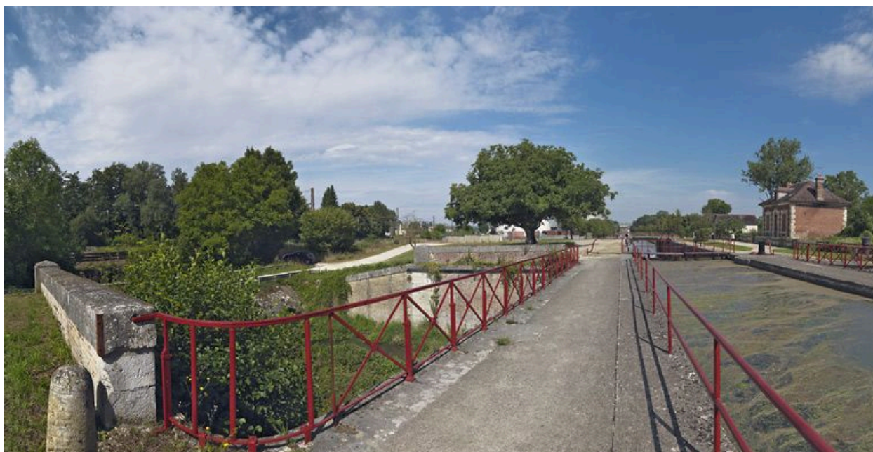
Pont-canal vu du dessus.
