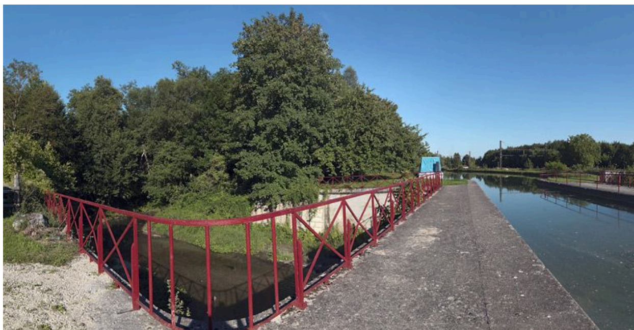
Sur le pont canal.
