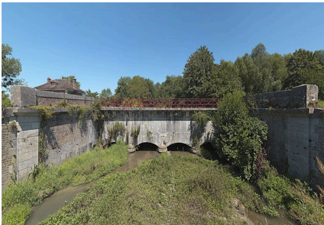
Arches du pont-canal vues de face.
